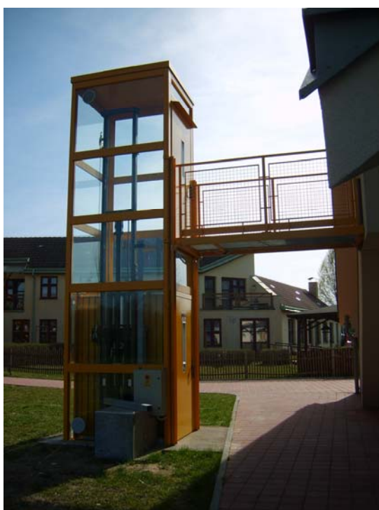
Obr. 2 – Výtah zabezpečující přístup do 2.patra
