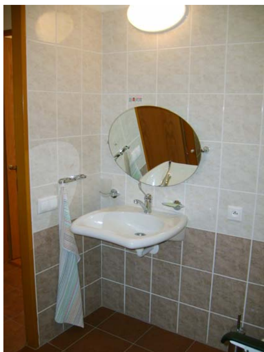
Obr. 8 – Umyvadlo s nastavitelným zrcadlem
