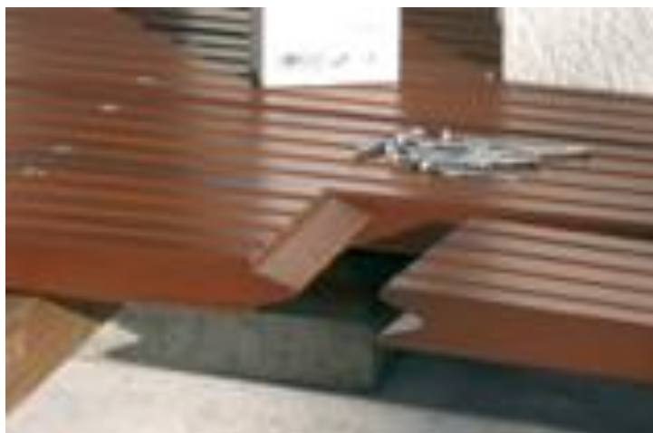
Obr. 35 Napojení prken mimo podkladní hranol (Au-mex s.r.o.)
