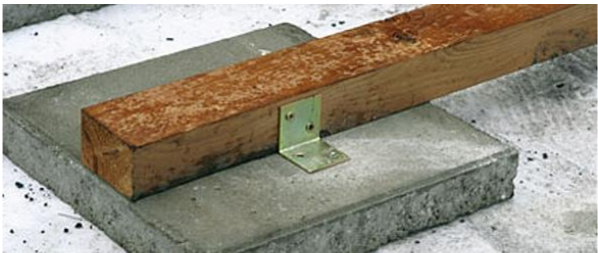
Obr. 33 Příklad ukotvení nosné konstrukce k podkladu ( http://www.floorwood.cz/clanky/jak-na-drevene-terasy/ )
