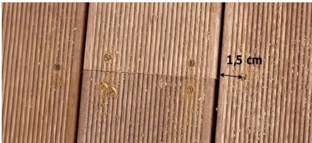
Obr. 34 Ukázka umístění vrutů ( www.floorwood.cz/clanky/jak-na-drevene-terasy/ )
