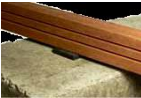
Obr. 31 Čtvercová gumová podložka pod nosnou konstrukcí ( www.prajsner.cz/data_3/soubory/112.pdf )
