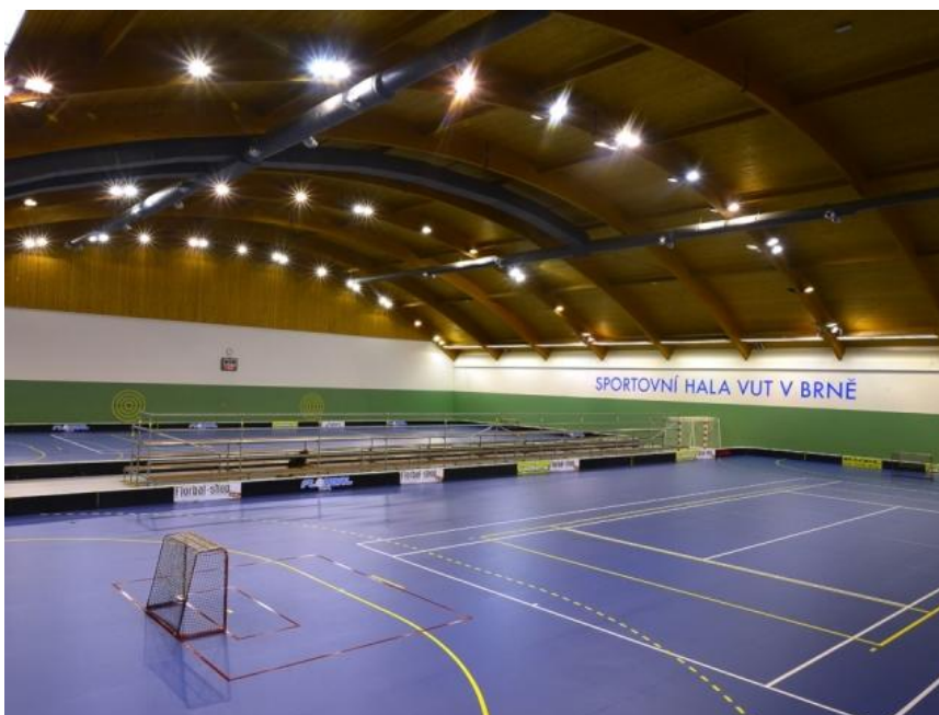
Obrázek 30 – Sportovní hala Pod Palackého vrchem [27]
