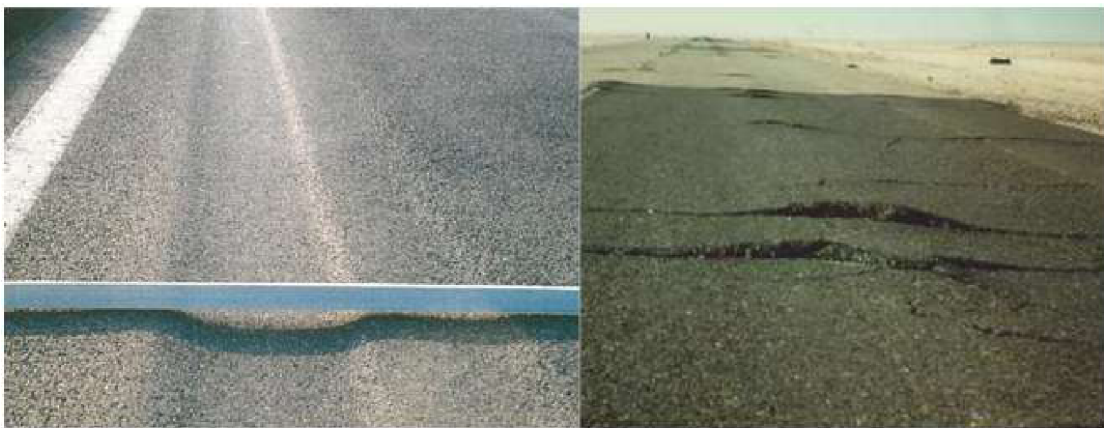
Obrázek 8: (a) vyjeté koleje, (b) mrazové trhliny [33]
