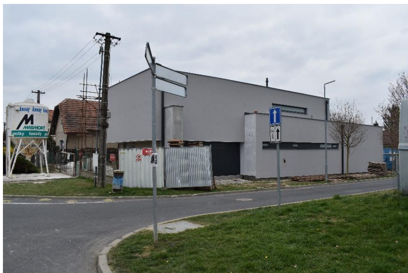
Obrázek č. 23 – ulice Průběžná a kontrast nové budovy se starou zástavbou v zadní části (vlastní foto, 2019)
