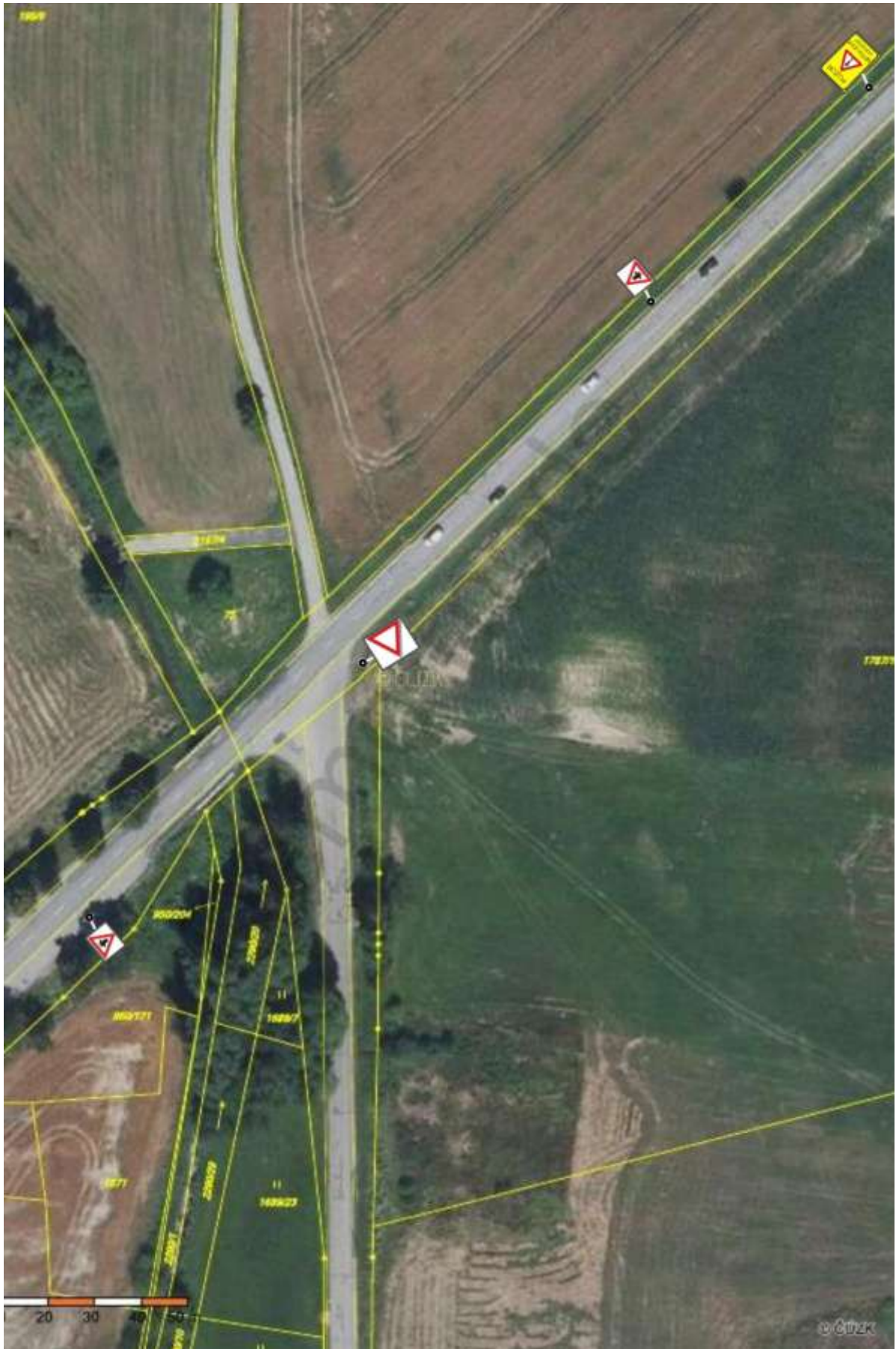
Obr. č. 15: Stávající stav kritického místa č. 3 [7], [18]
