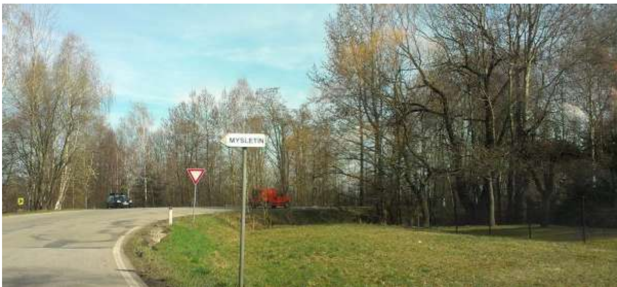
Obr. č. 9: Pohled na kritické místo č. 2
