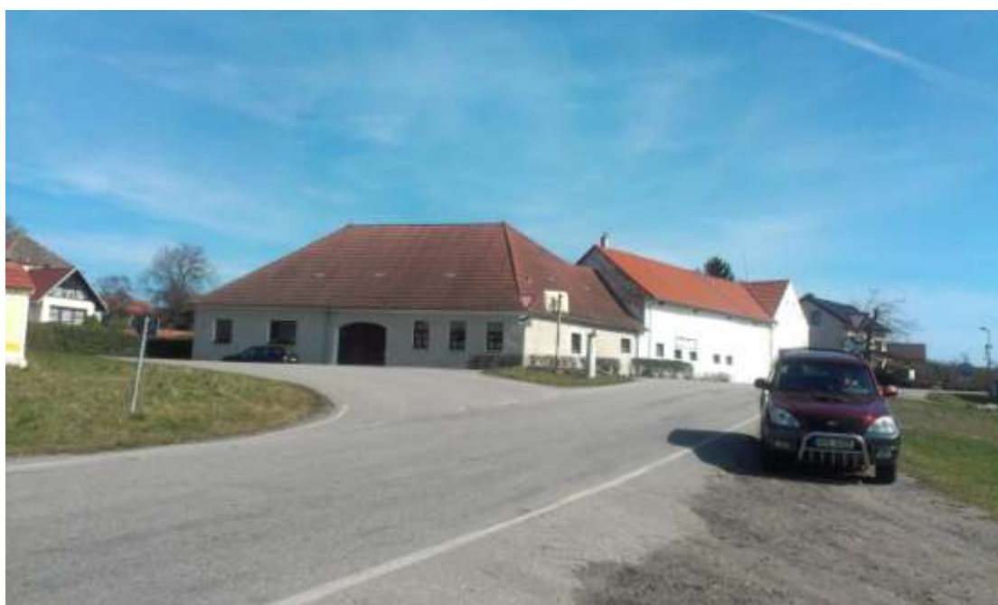
Obr. č. 23: Pohled na kritické místo č. 4
