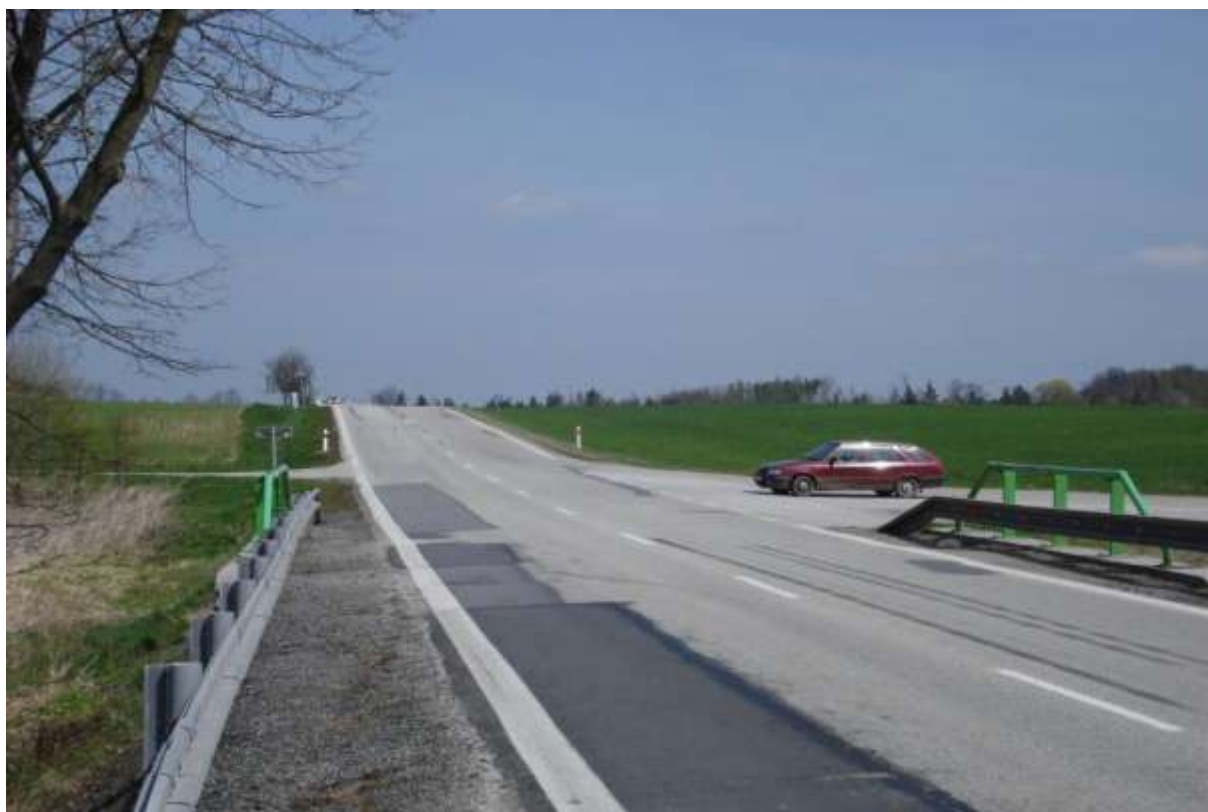
Obr. č. 17: Pohled na kritické místo č. 3
