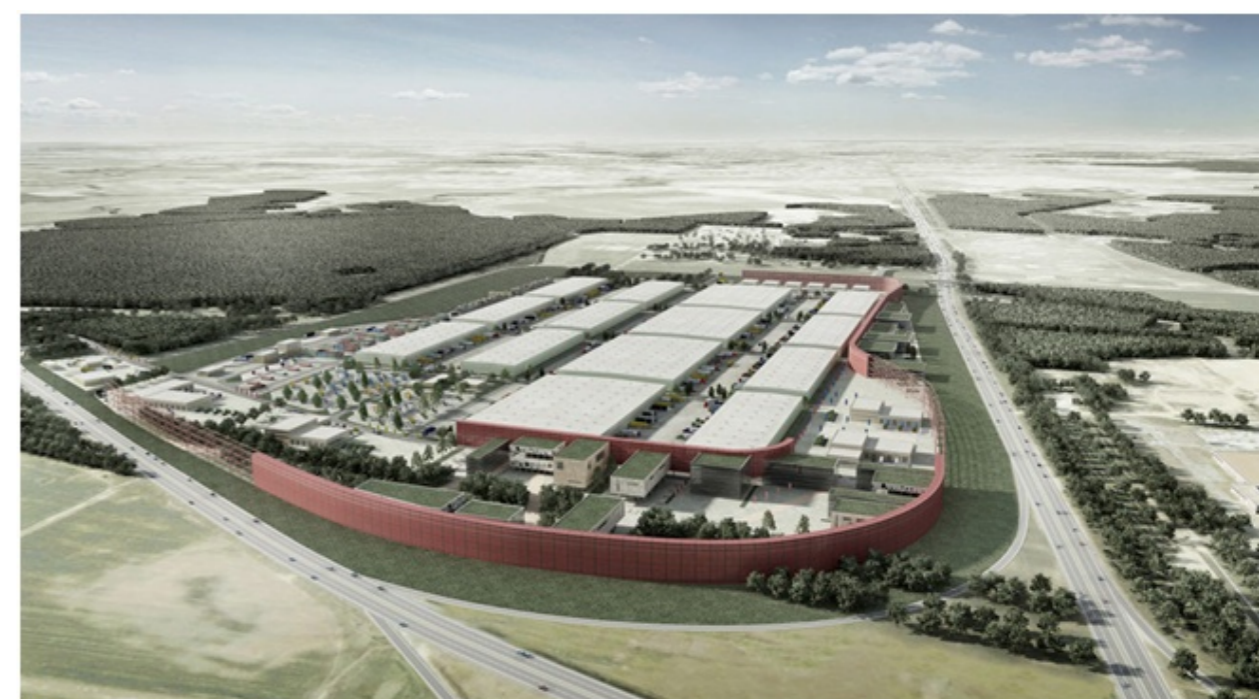
Obr. 7 - Prilesie Logistic Center . Zdroj: isl.org (2018)
