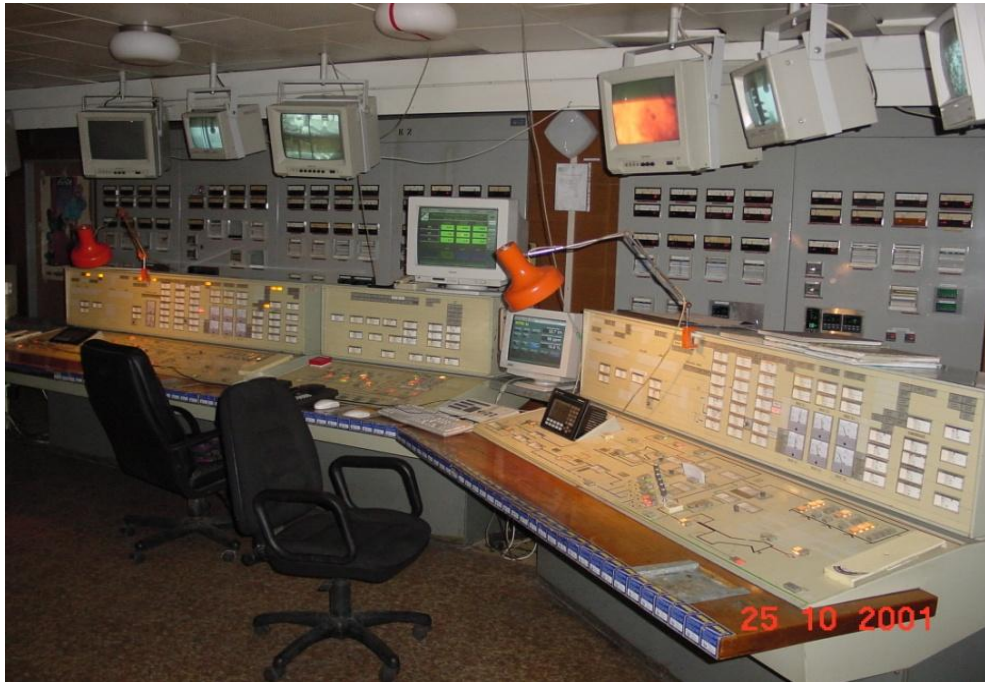
Příloha č. 3 - Fotografie velínu před rekonstrukcí (SAKO Brno, a.s., 2016)
