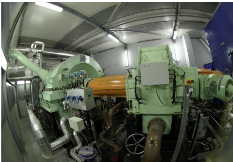
Příloha č. 7 - Fotografie současné turbíny 22,7 MW (SAKO Brno, a.s., 2016)
