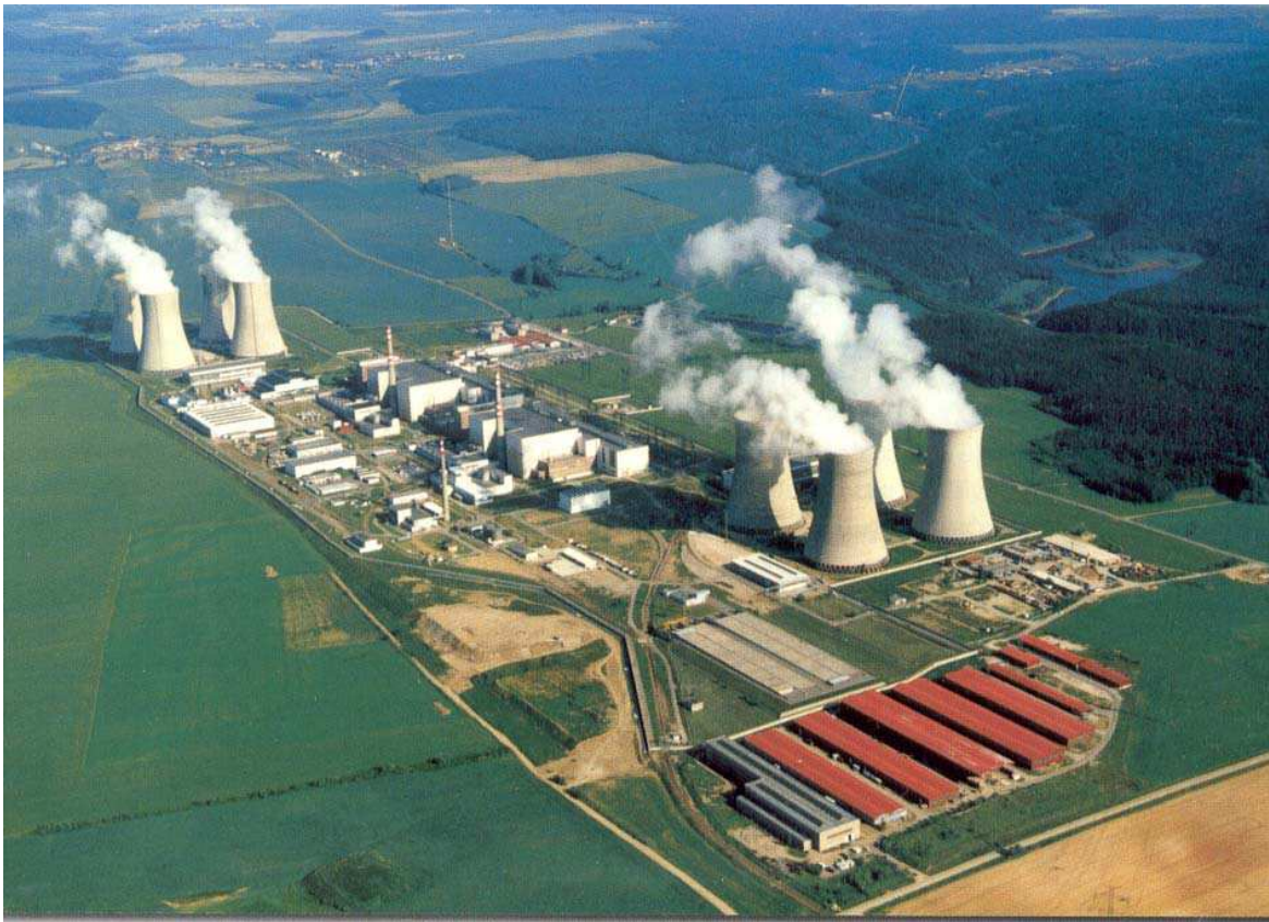
Jaderná elektrárna Dukovany
