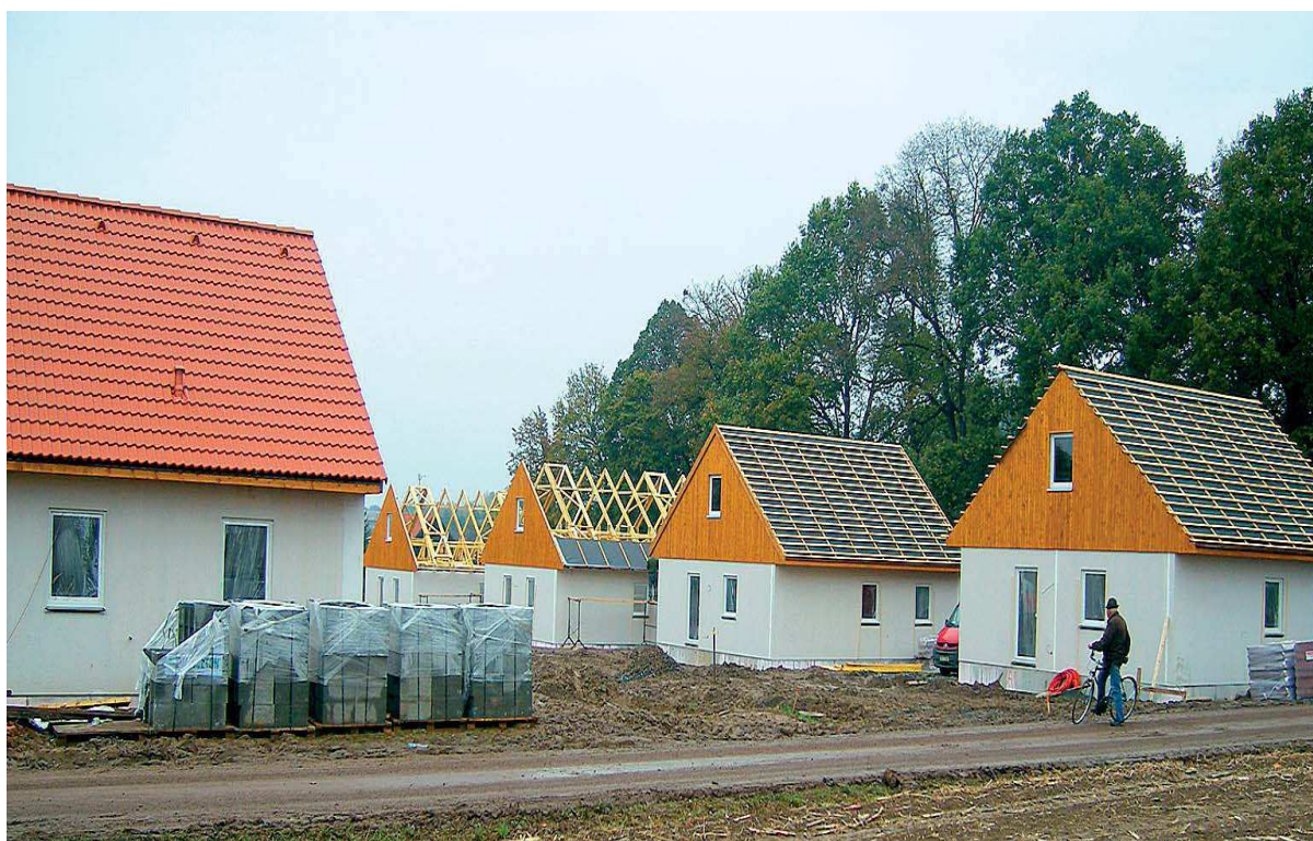
Výstavba nových domů po povodních v roce 2009
