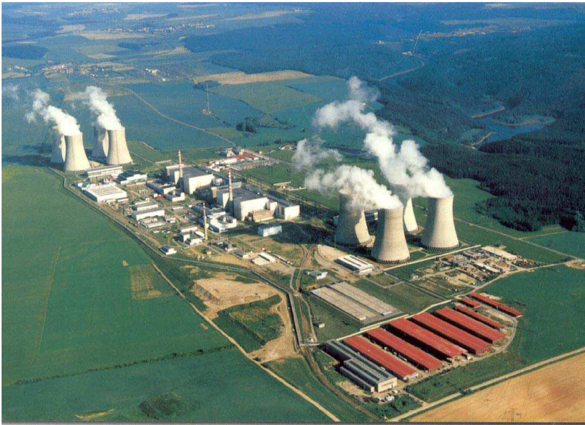
Jaderná elektrárna Dukovany
