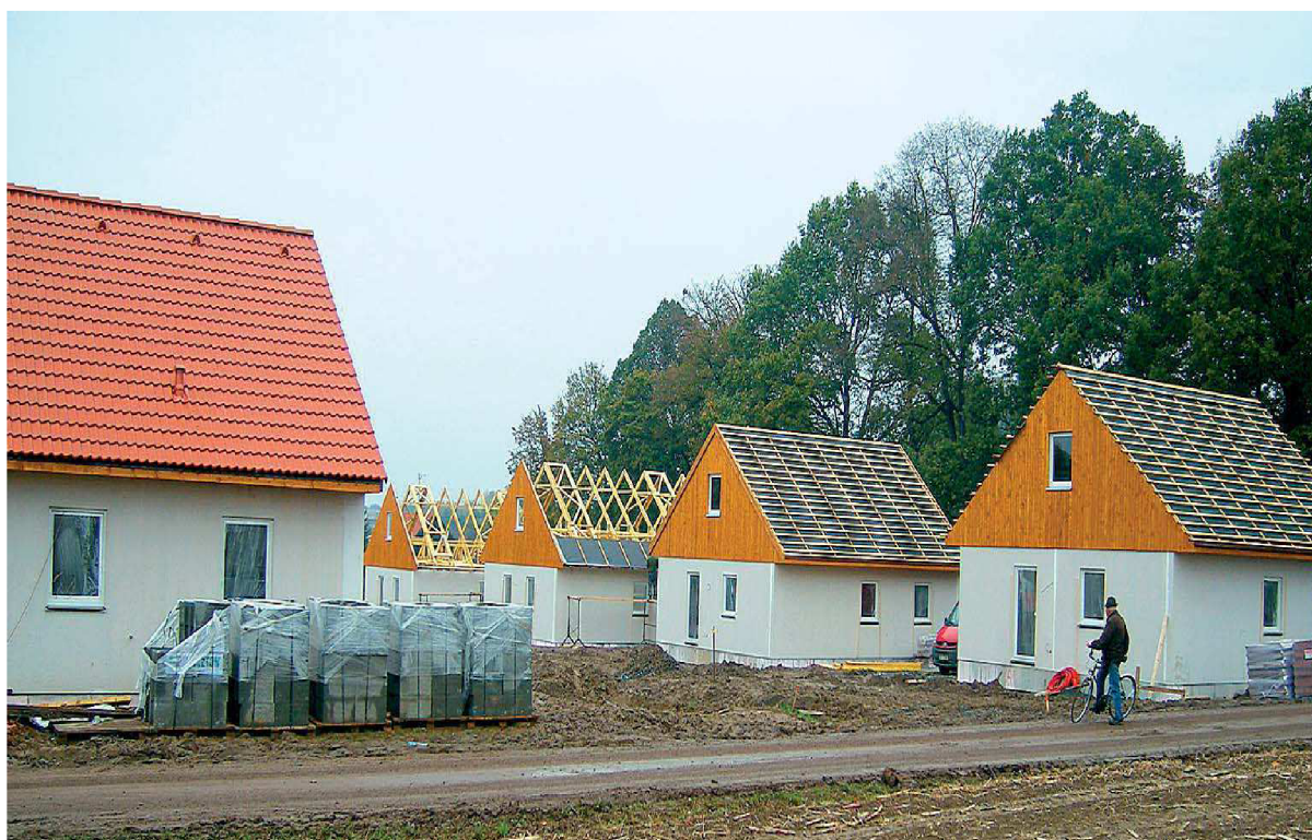
Výstavba nových domů po povodních v roce 2009
