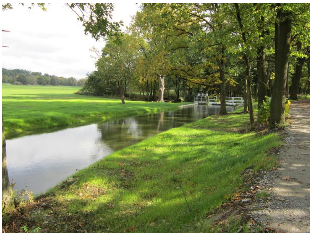
foto č. 5 – stav po realizaci
