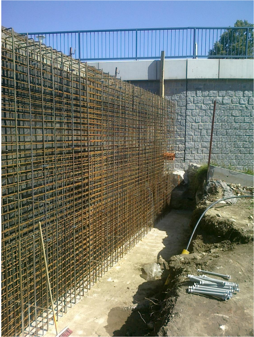
foto č. 7 – stav při realizaci
