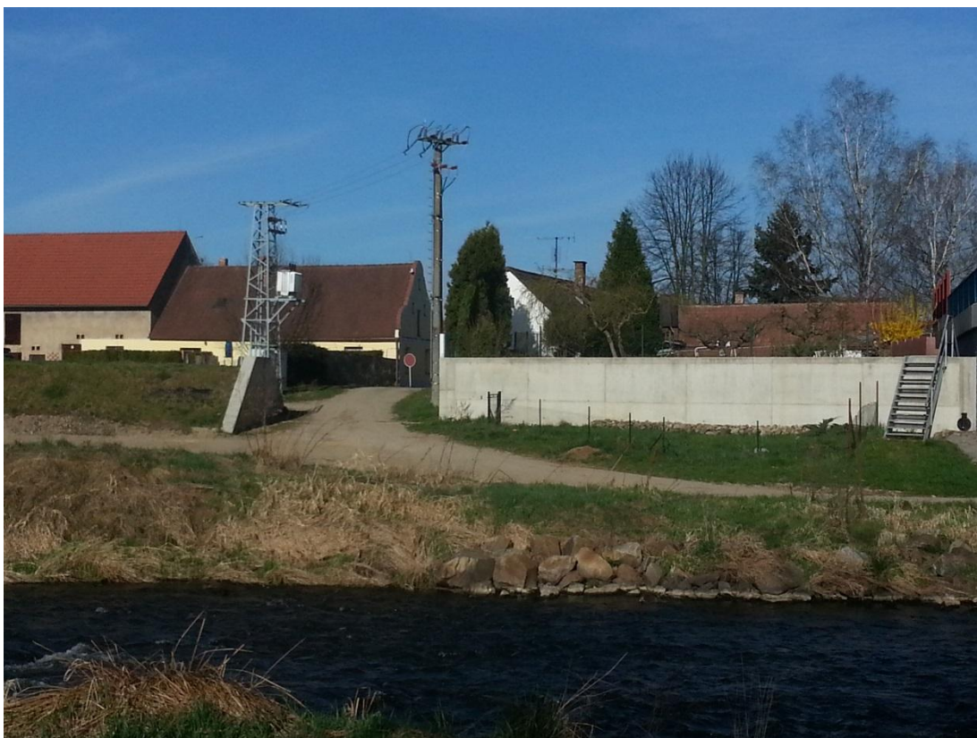
foto č. 8 – stav po realizaci
