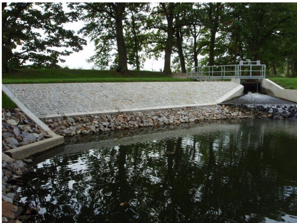
foto č. 4 – stav při realizaci
