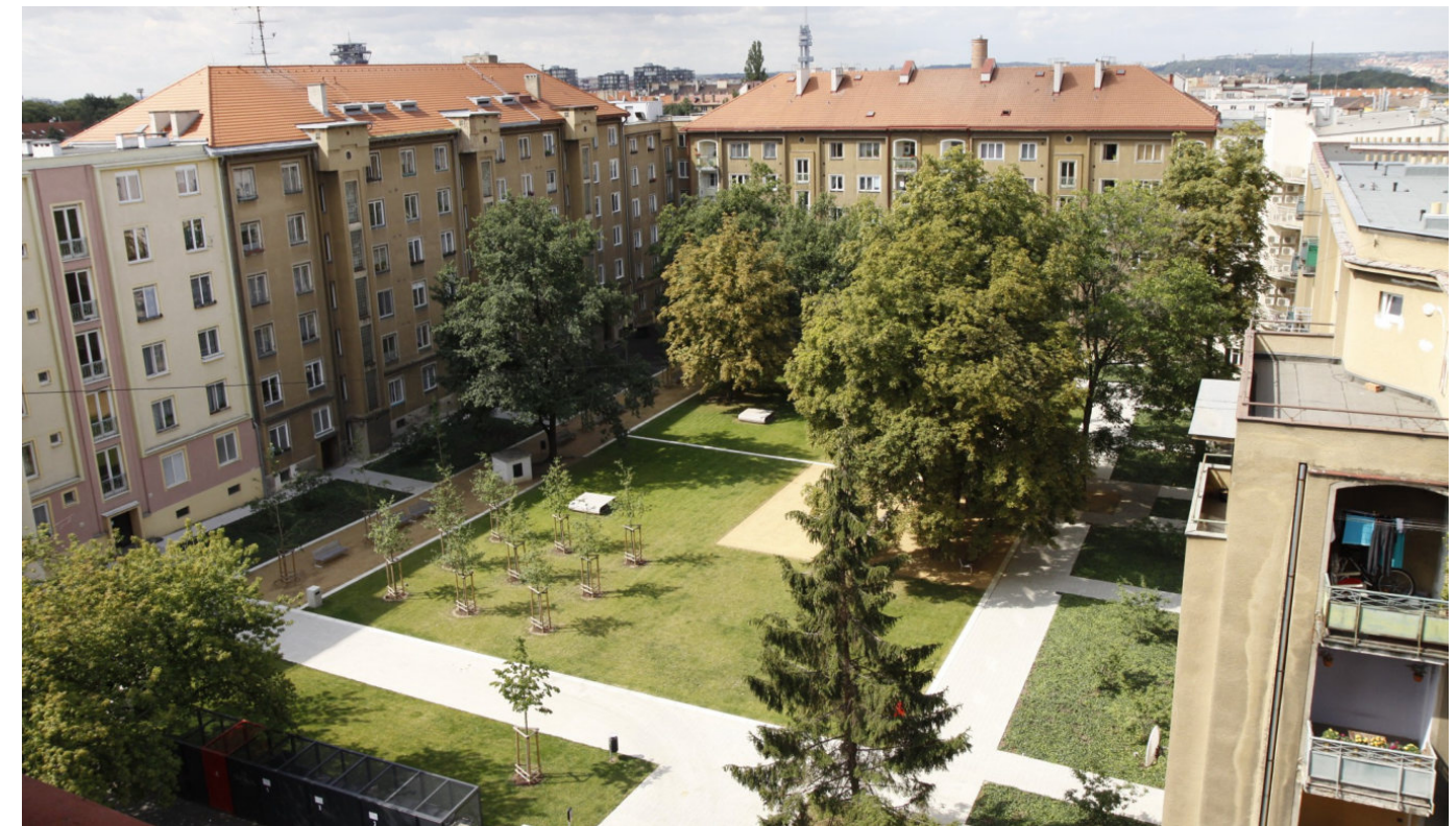
Obr. 12: Vnitroblok Za Žižkovskou vozovnou - celkový pohled (zdroj: www.szuz.cz)
