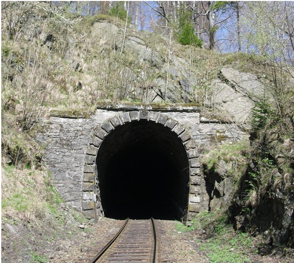
Obr. 2-2: Pohled na jihozápadní portál tunelu – ve směru od obce Hrubá Voda (foto: autor)
