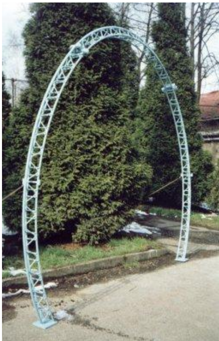
Obr. 6-4: Výztužný oblouk ASTA 50SL firmy Ankra – pohled (vlevo) [25] a okótovaný průřez (vpravo)
