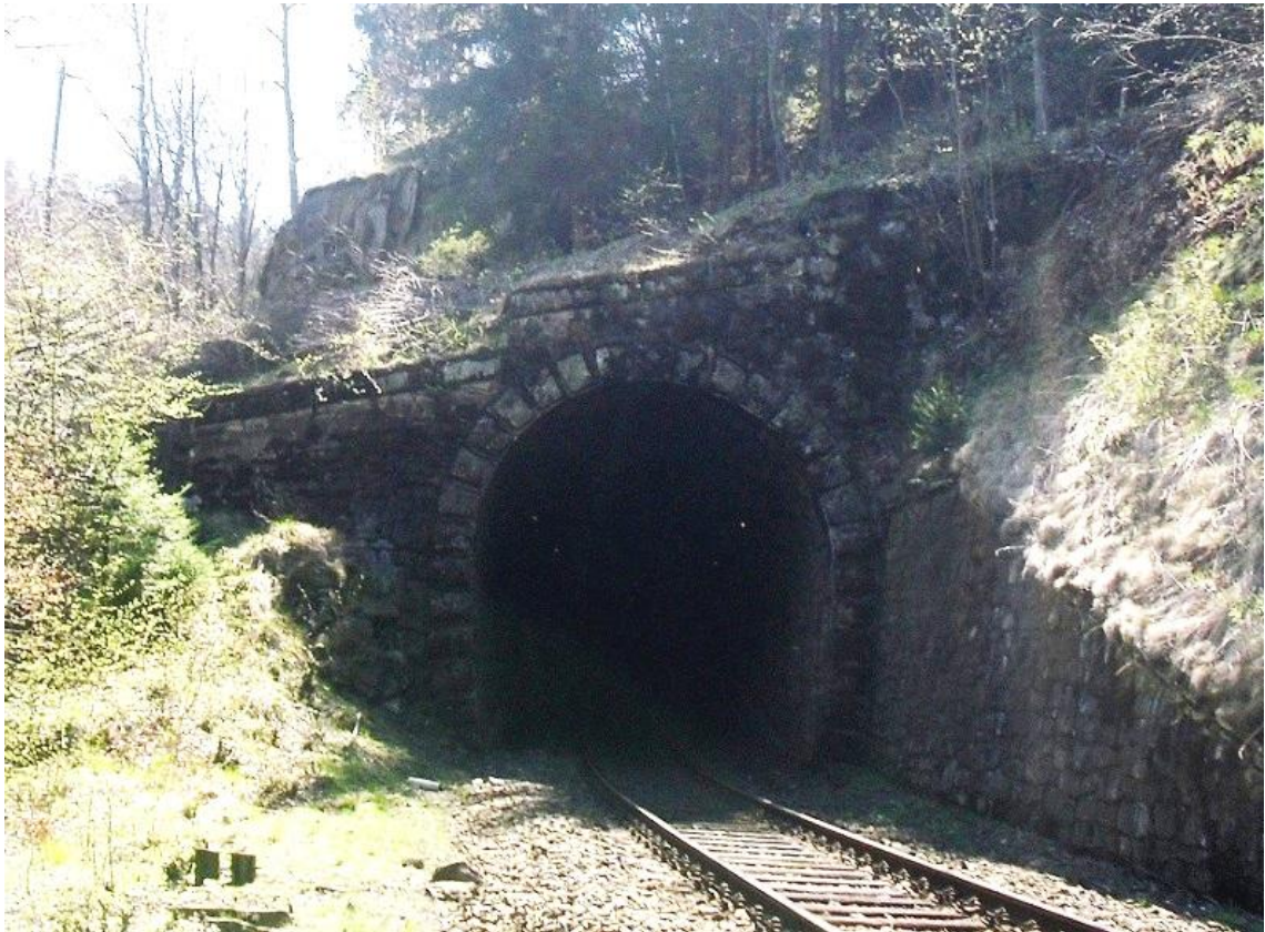
Obr. 2-3: Pohled na severovýchodní portál tunelu – ve směru od obce Domašov nad Bystřicí (foto: autor)
