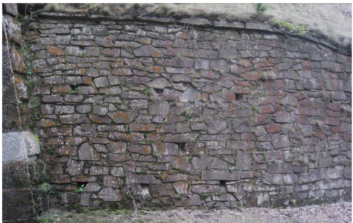
Obr. 2-7: Zárubní zeď u severovýchodního portálu tunelu [13]
