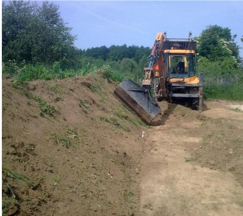
Obr. 4-4: Stabilizace stěn výkopu svahováním (foto: autor)
