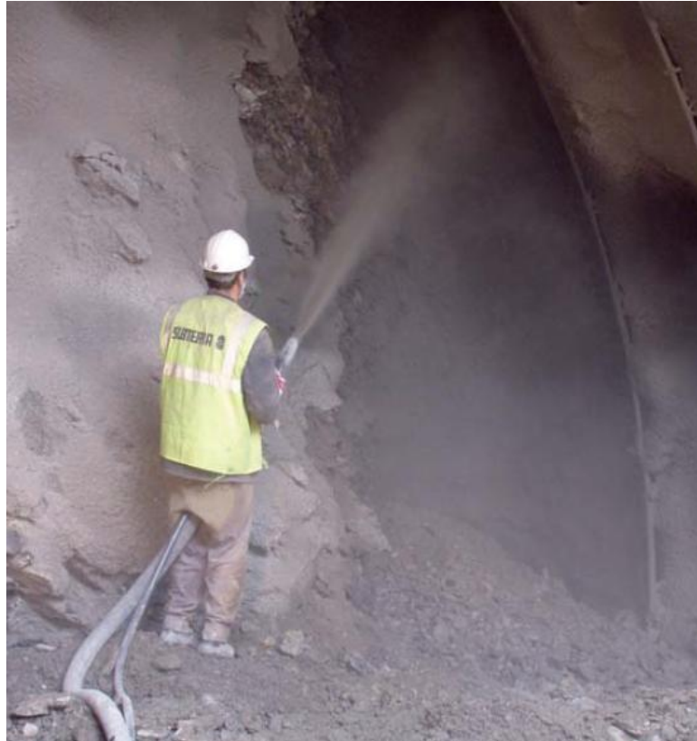
Obr. 4-8: Ruční způsob aplikace stříkaného betonu suchou cestou [23]
