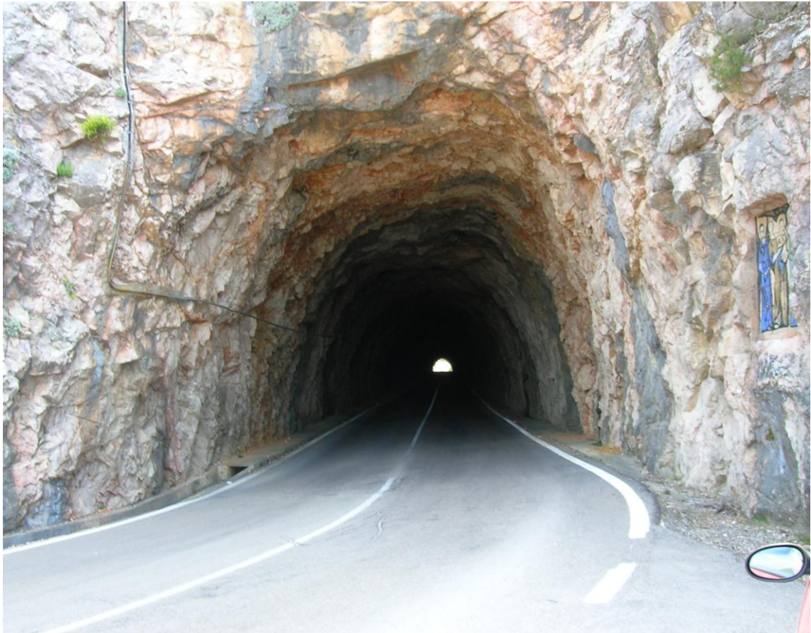
Obr. 4-7: Nezajištěný (nepodepřený) výrub – Mallorca, Španělsko (foto: autor)
