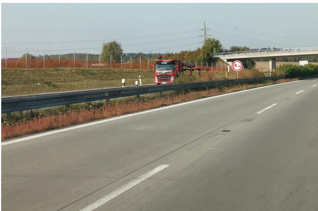
Obrázek 10. Bohatý porost lebedy různosemenné ( Atriplex micrantha ), typicky se zbarvující v době dozrávání plodů, ve středním dělicím pásu dálnice D1 (345,0–345,5 km, směr Ostrava), v popředí typické rostliny obrazené po údržbové seči, v pozadí mezi svodidly neposečené vzrostlé rostliny, 24.9.2020. – Foto P. Kocián.
