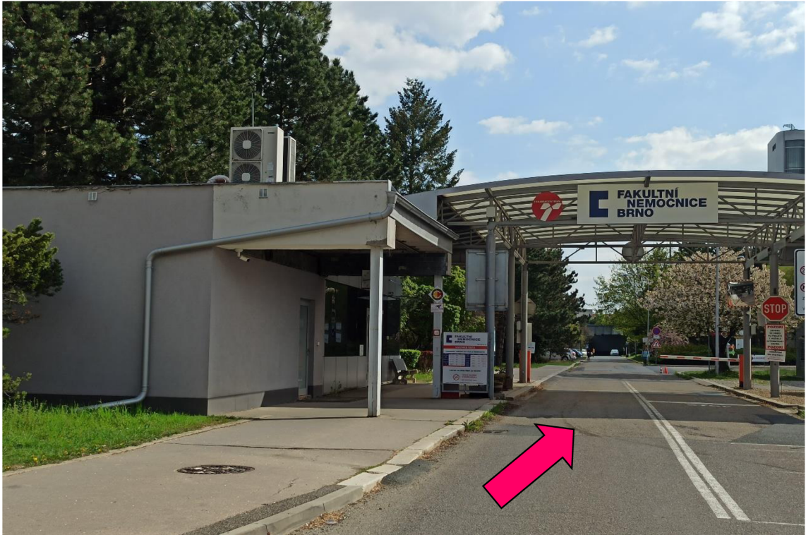
Příloha 3: Vstup do FN Brno pro převozové služby a ženy k porodu
