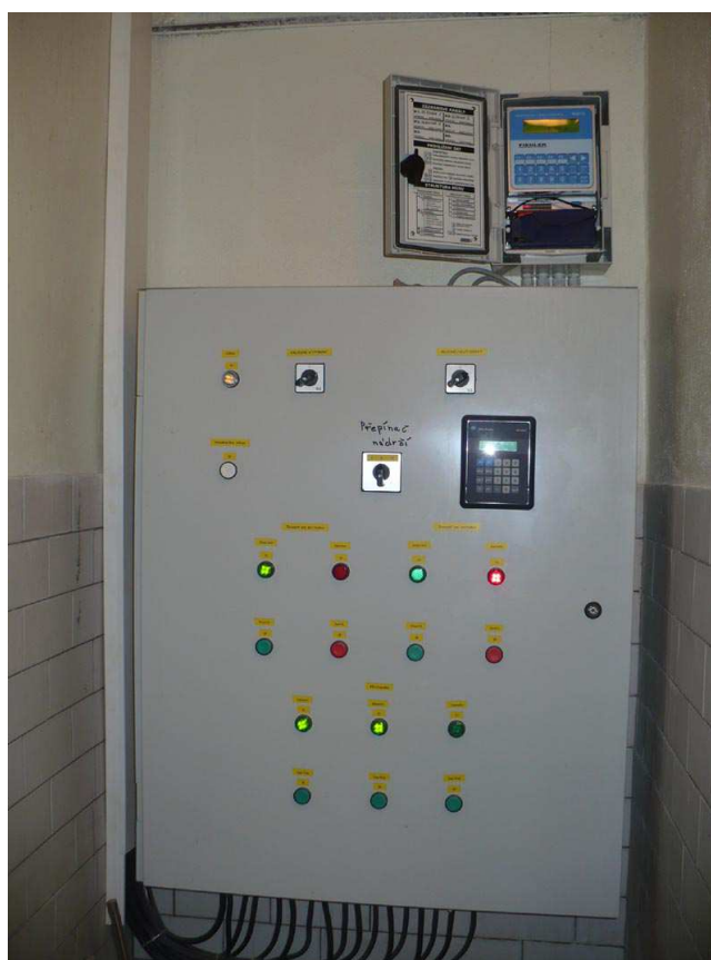
Obrázek 4 Řídicí jednotka systému vymíracích nádrží
