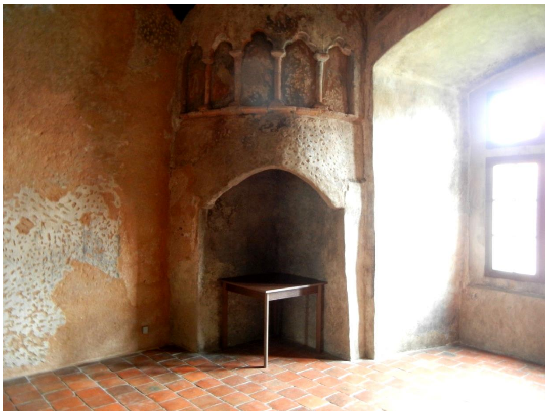
Obr. 32: Zachovalý válcový krb zdobený slepými arkádami, ve kterých jsou dodnes patrné zbytky maleb znázorňujících heraldické znaky pánů z Hradce (foto autor).
