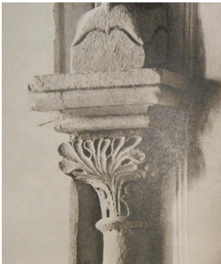
Obr. 34: Klenební přípora s košovitou hlavicí v raně gotické lodi kaple (převzato z Menclová 1972a, 188).
