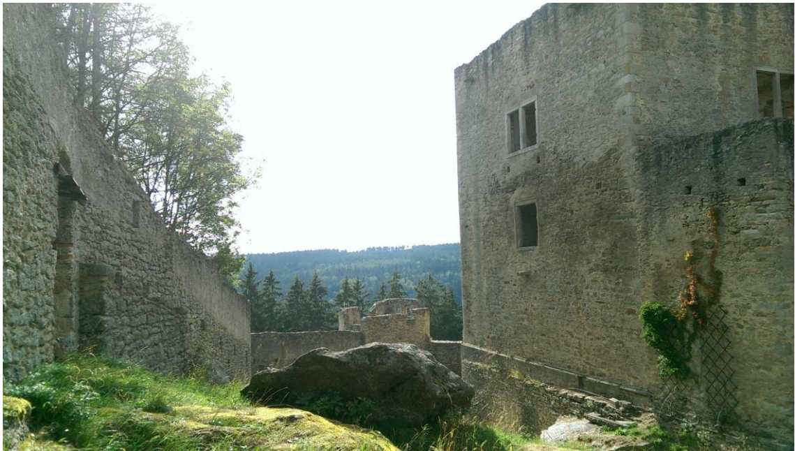
Obr. 90: Po pravé straně je patrný donjon postavený ve 14. století vně hradby a částečně překrývající původní vstup (foto autor).
