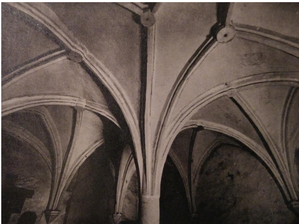
Obr. 123: Klenba komory se středním sloupem za velkou věží ve východní části hradu (převzato z Menclová 1972b, 261).
