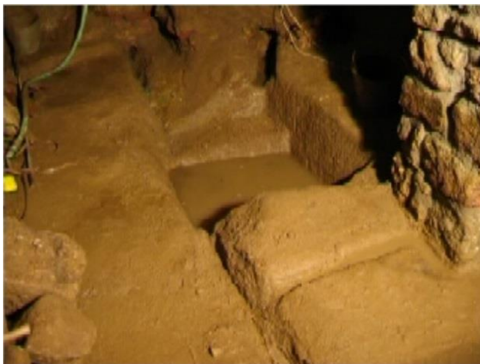
Obr. 108: Jímka, do které byla kanálky v podlaze vedena voda z nádvoří (převzato z Červák – Šindelář – Vácha 2006).
