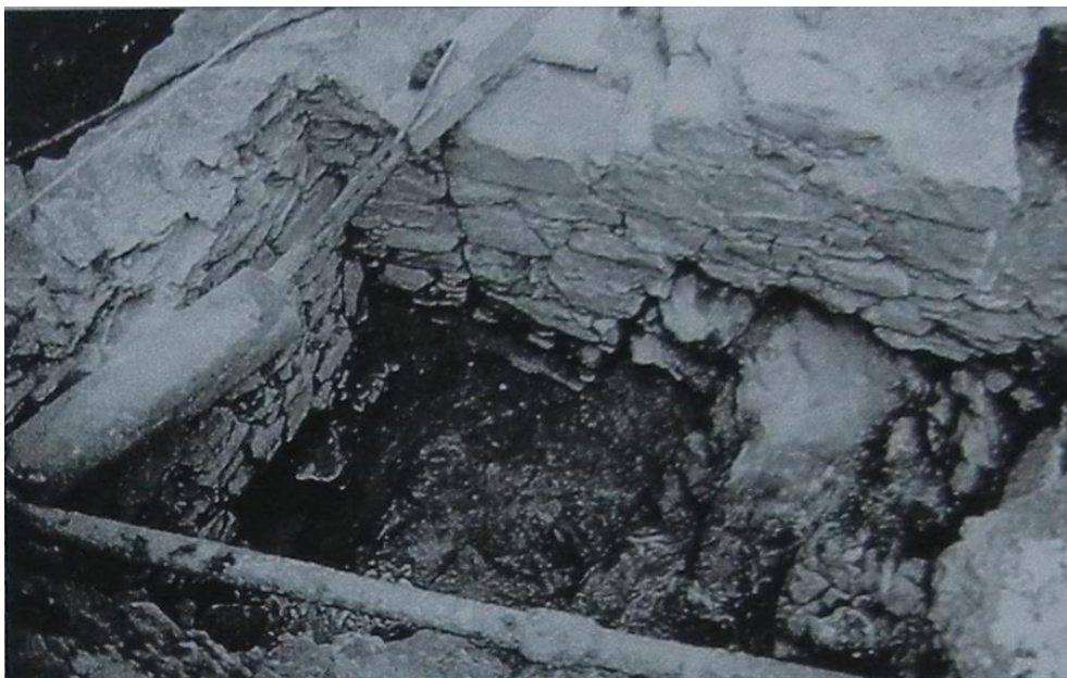
Obr. 130: Sonda 7 na druhém nádvoří. Pohled do interiéru brány od severu (převzato z Ernée 1999, 27).
