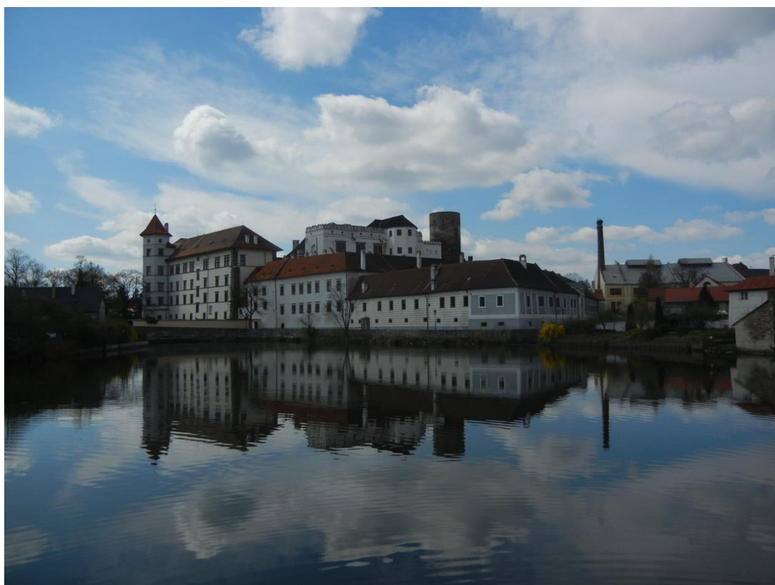
Obr. 38: Pohled na hrad od jihovýchodu. V popředí rybník Vajgar (foto autor).
