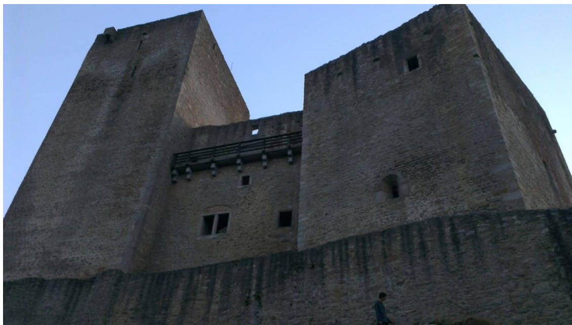
Obr. 87: Románské jádro hradu. Na levé straně velká čtverhranná věž, uprostřed románský palác a po pravé straně menší čtverhranná věž s kaplí, včetně patrného románského okénka (foto autor).
