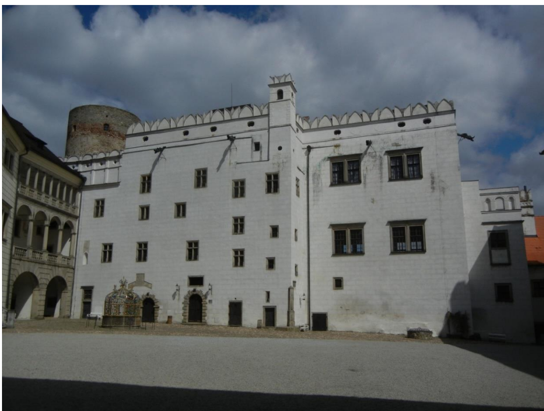
Obr. 24: Gotický palác. Dnešní stav po renesančních úpravách. Nejstarší části paláce jsou skryty přístavbou nádvořího traktu ze 14. století a prostorově se
