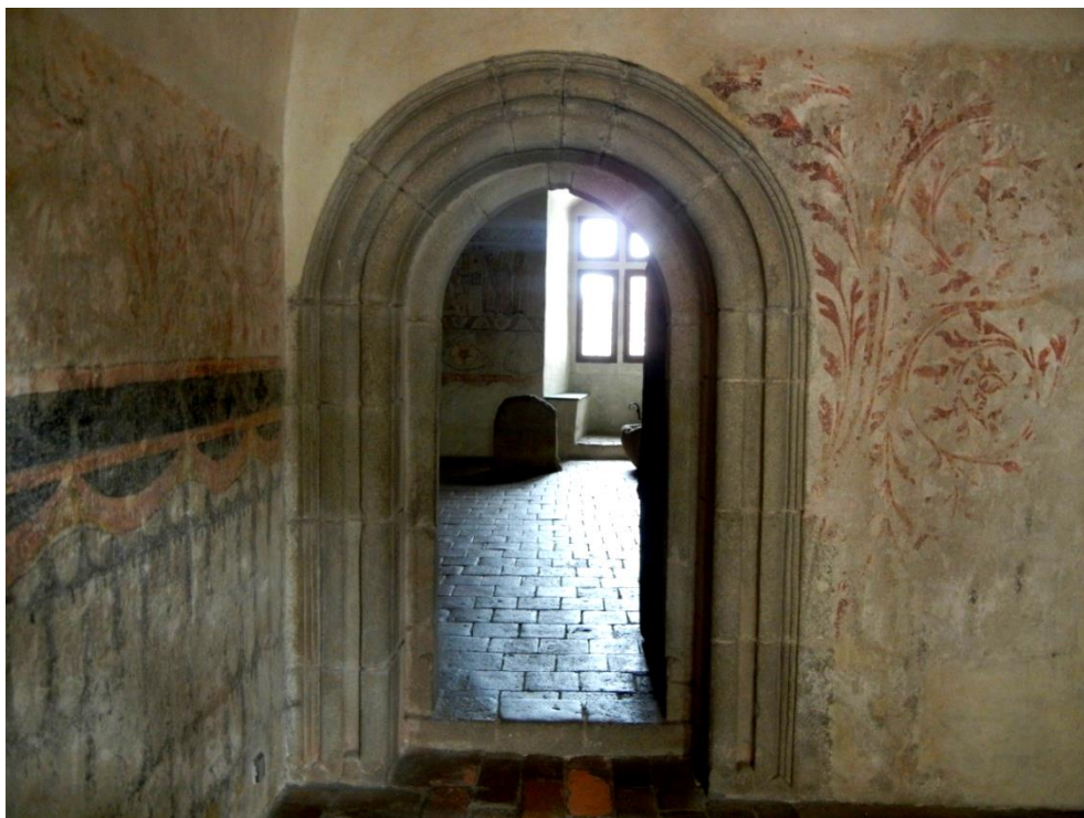
Obr. 29: Půlkruhový ústupkový portál ze 13. století. Tímto portálem se vstupovalo do paláce před přístavbou nádvořího traktu ve 14. století (foto autor).
