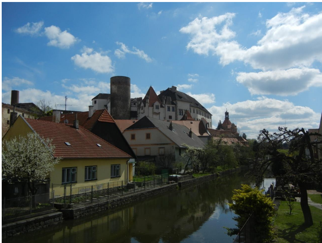
Obr. 21: Jindřichův Hradec. Pohled od severozápadu (foto auto)
