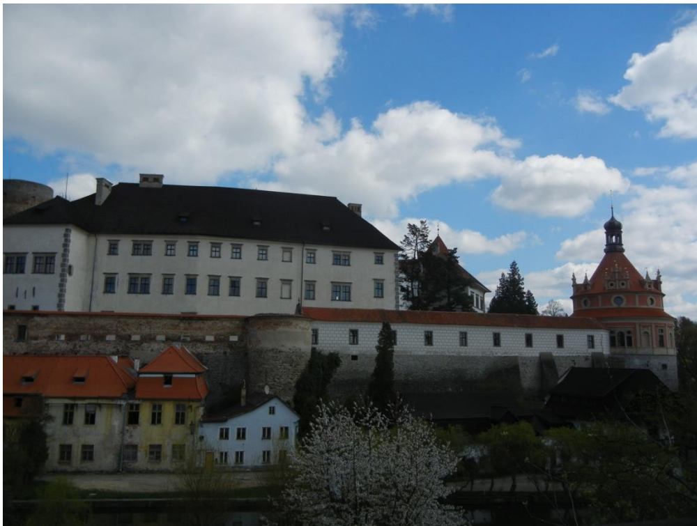
Obr. 45: Pozdně gotické opevnění se zachovalou polookrouhlou baštou (foto autor).
