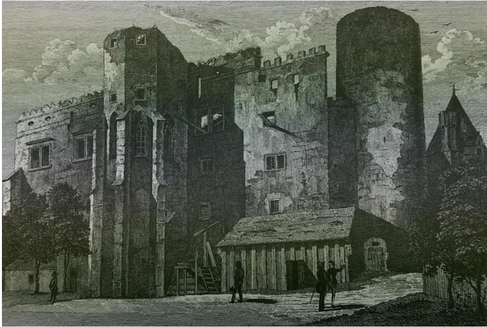
Obr. 46: Gotický palác po požáru roku 1773. Malba J. Malocha z poloviny 19. století (převzato z Heber 2008, 127).
