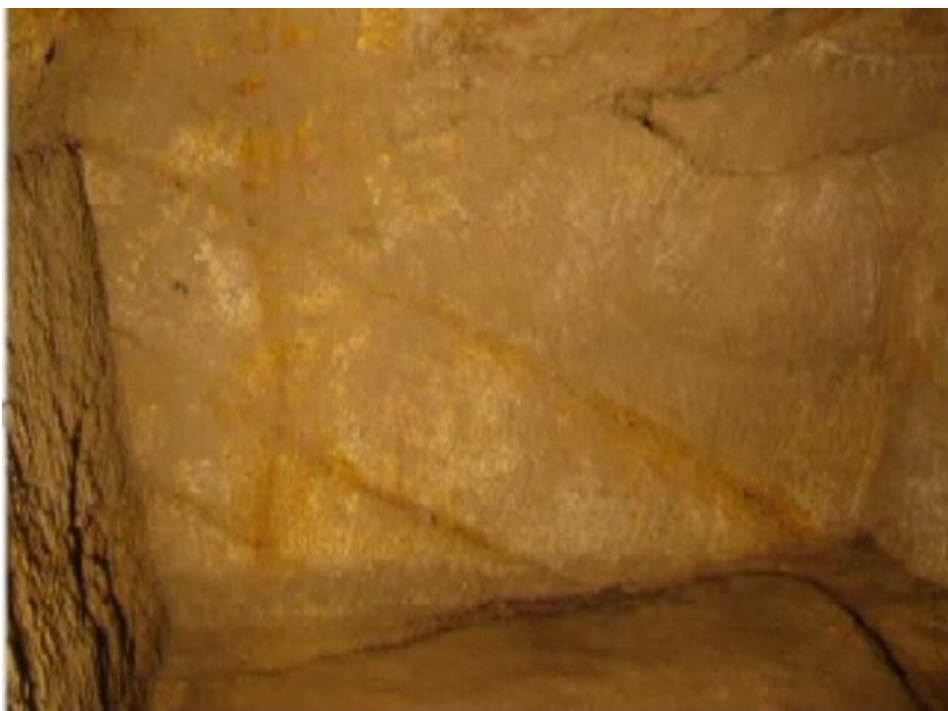
Obr. 107: Pukliny ve skále, které přivádí vodu do podzemí (převzato z Červák – Šindelář – Vácha 2006).
