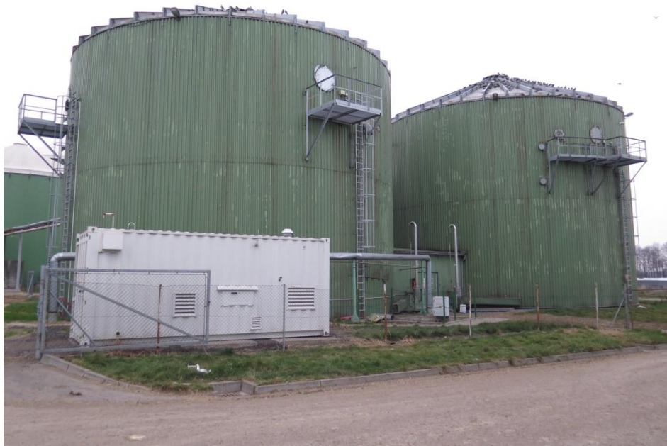
Obr. 3.9 Umístění výzkumného kontejneru a přívodní potrubí do technologie
