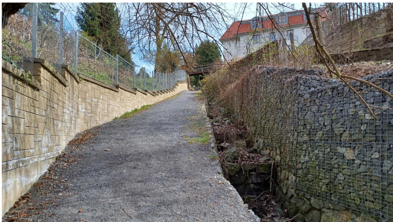
Obr. 16: Fotka znázorňující nově vybudovanou kamennou zeď (vpravo) a novější podezdívku plotu (vlevo). Je zde také vidět upravené koryto s velkými kameny (vpravo). Rekonstrukci spodní části se naštěstí podařilo zabránit (© Vlček 2024).
