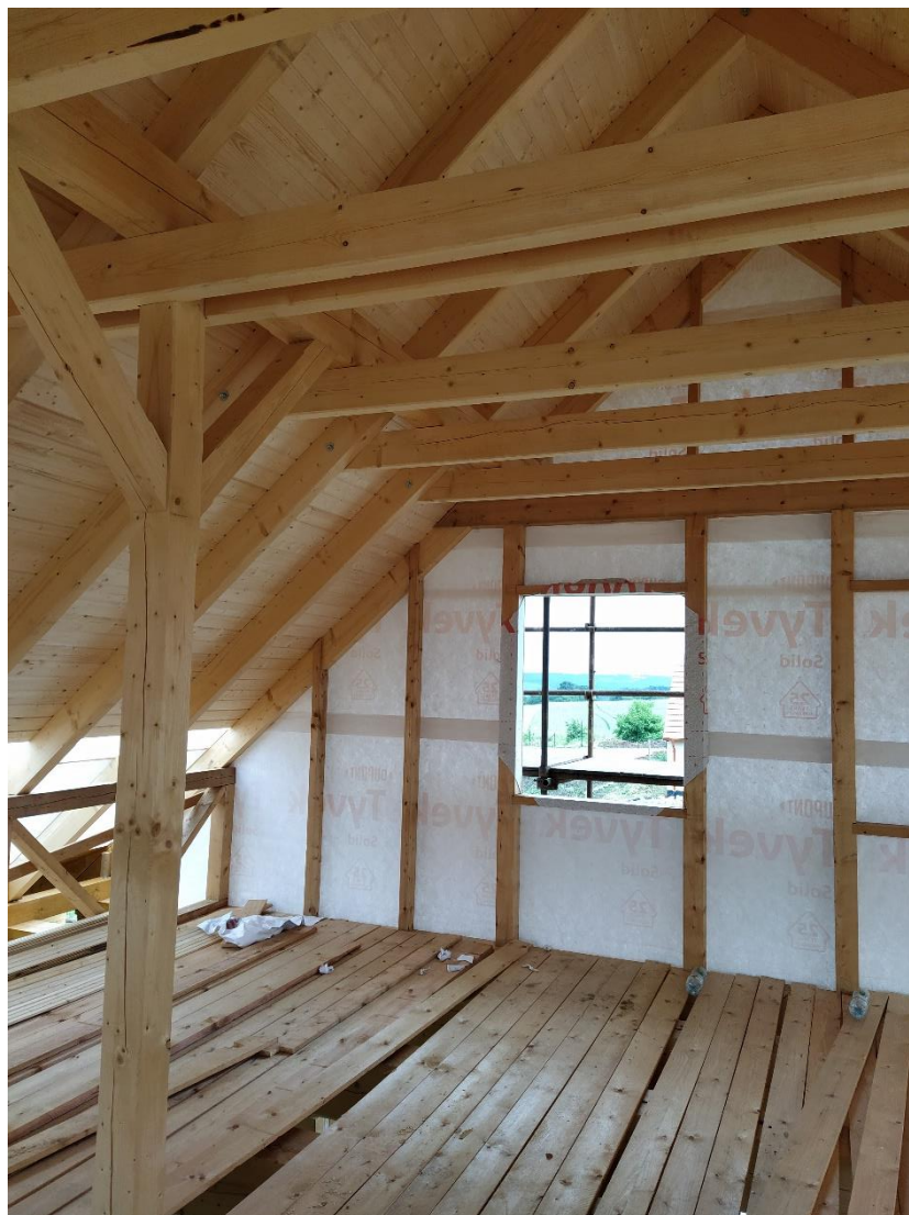
Obrázek 24 Sloupková konstrukce stěny štítu (archiv autora)
