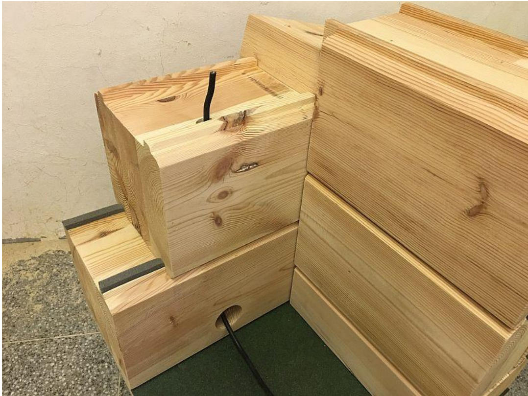
Obrázek 15 Předem vyfrézované otvory pro rozvody v BSH roubení [20]
