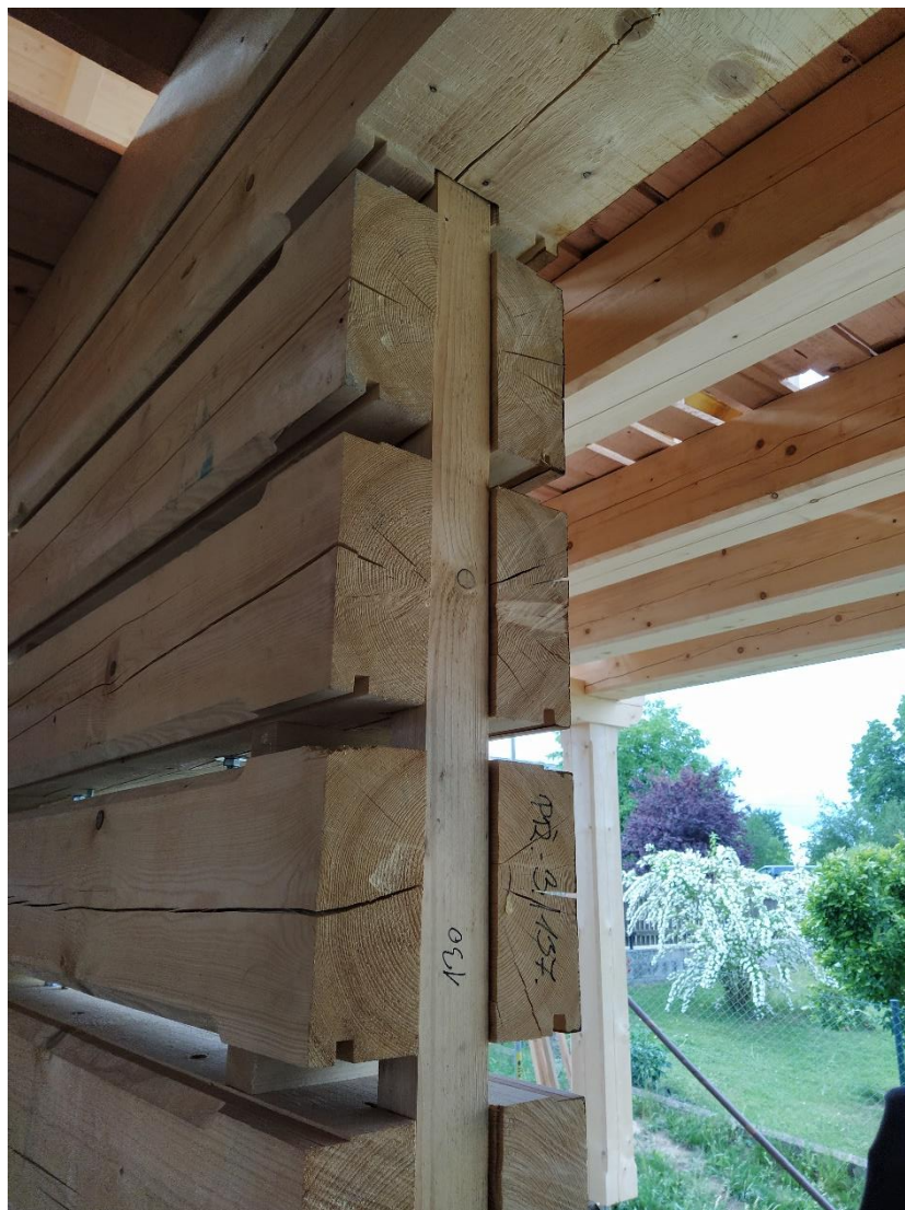
Obrázek 19 Provedení spár a provedení sloupku (archiv autora)
