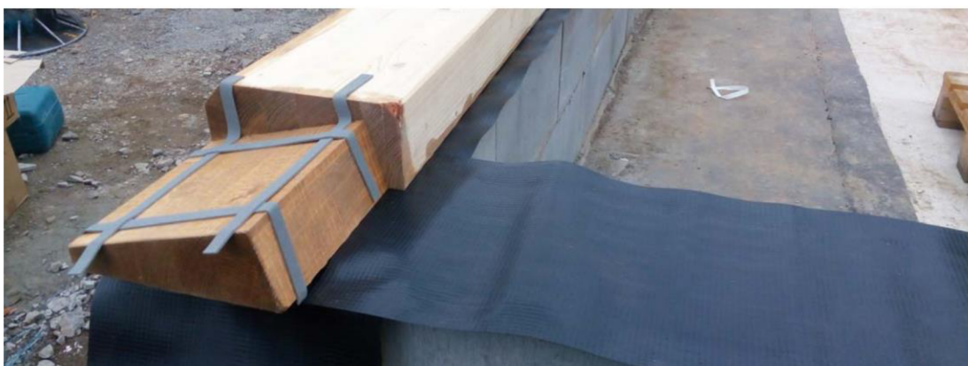
Obrázek 22 Řešení netěsnosti rohového spoje PU páskami [12]
