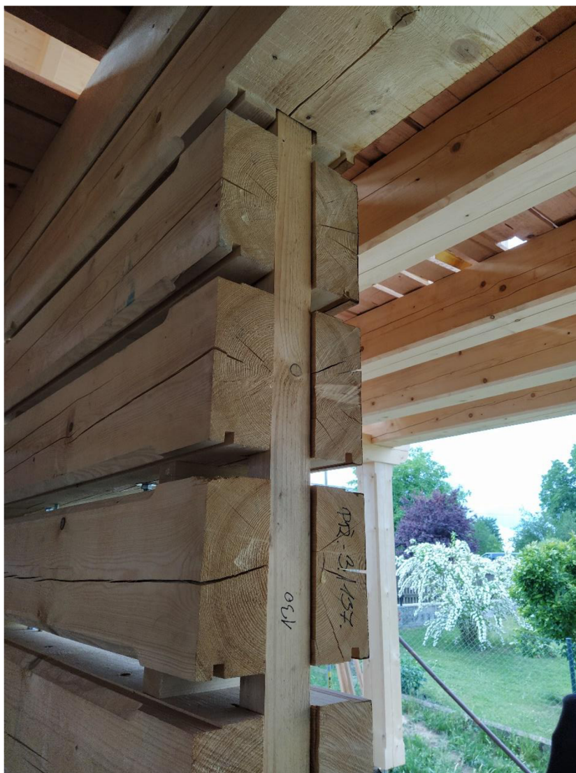
Obrázek 19 Provedení spár a provedení sloupku (archiv autora)
