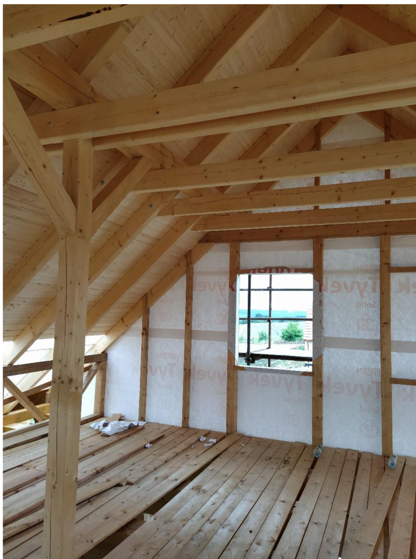
Obrázek 24 Sloupková konstrukce stěny štítu (archiv autora)
