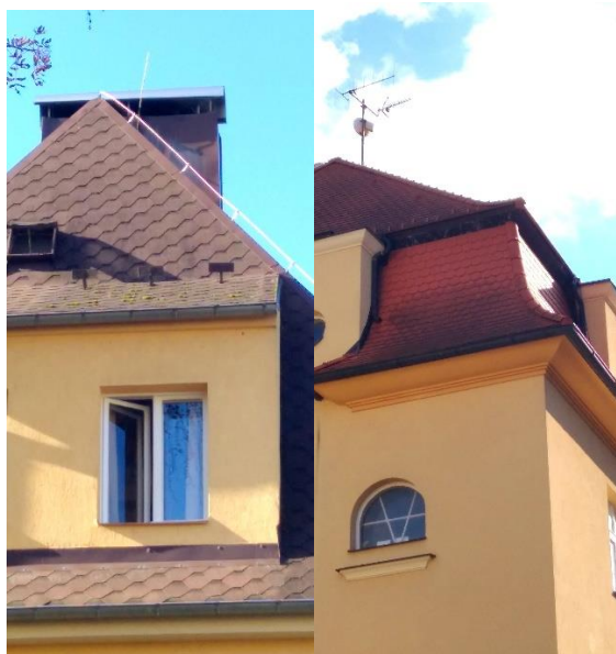
Obr. 10: Ukázka znečištění střech mikrobiologickými povlaky.
