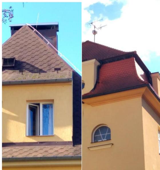
Obr. 10: Ukázka znečištění střech mikrobiologickými povlaky.
