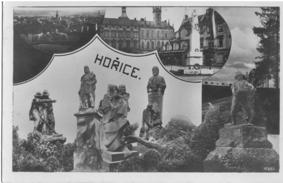
54 Muž práce a další pamětihodnosti Hořic (pohlednice prošlá poštou 18. 8. 1934)
