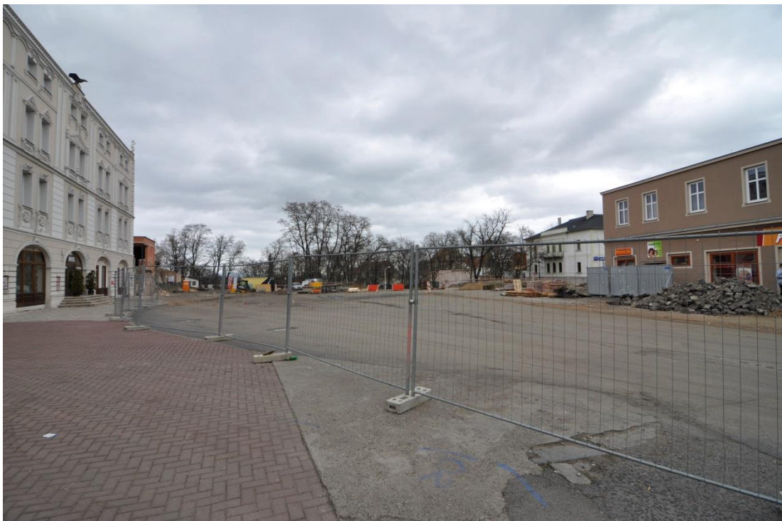
Foto č. 6: Rekonstruované autobusové nádraží na moderní terminál
