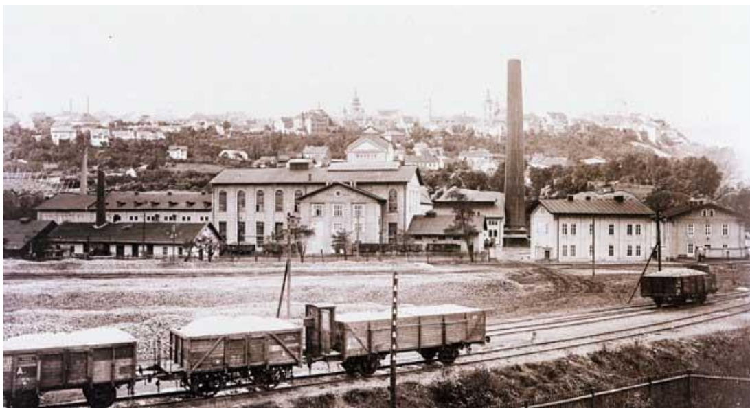
Obrázek č. 3: Pohled na železnici a budovu cukrovaru (Zdroj: http://www.muzeumzatec.cz )
