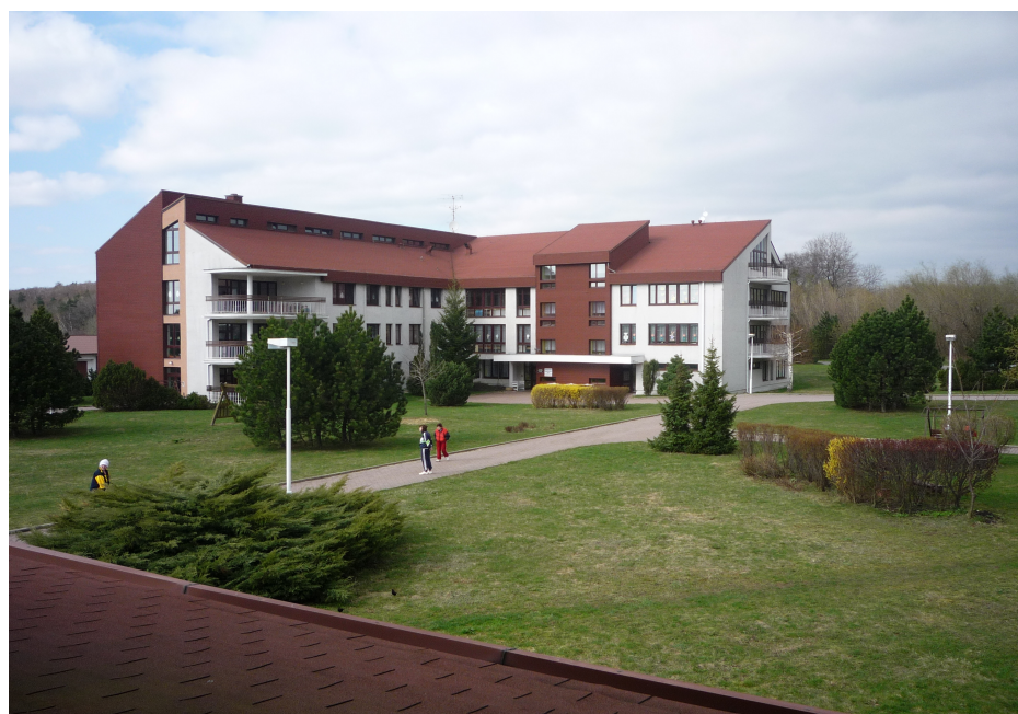
Obr. 2: DZP Javorník – hlavní budova (2010)
