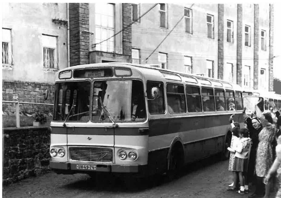
Obr. 1: ÚSP Hostýn – hlavní budova (1979)
