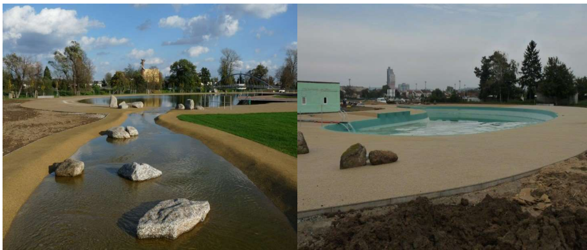
Obr. 4.5 Pohled na biotop Brno-jih po realizaci (vlevo) a v průběhu realizace (vpravo) [29]
