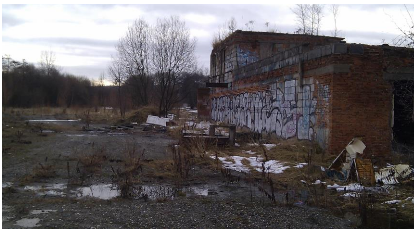
Obr. č. 23 - Pohled v roce 2011 směrem k ulici Jelení zdroj VRV – Koterová
