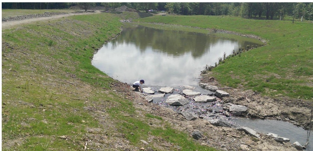
Obr. č. 27 - Realizace tůně v oblasti Na Vysoké zdroj VRV – Koterová
