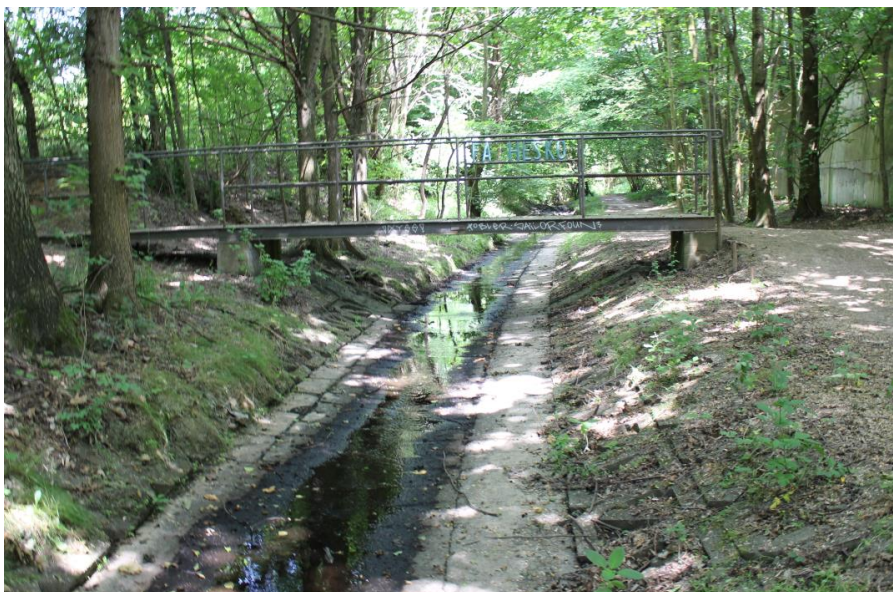
Obr. č. 37 - Urbanizované koryto. Zdroj: Miroslav Zámola 2018
