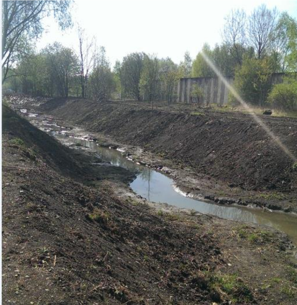
Obr. č. 30 - Ukázka meandru po realizaci revitalizace koryta po odtoku z tůně v oblasti Na Vysoké zdroj VRV – Koterová
