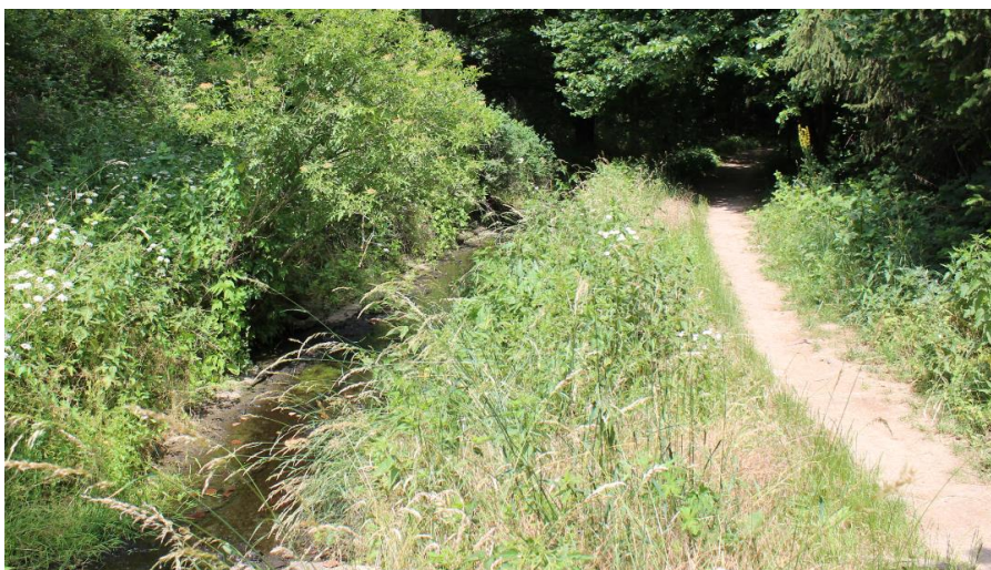
Obr. č. 36 - Urbanizované koryto. Zdroj: Miroslav Zámola 2018
