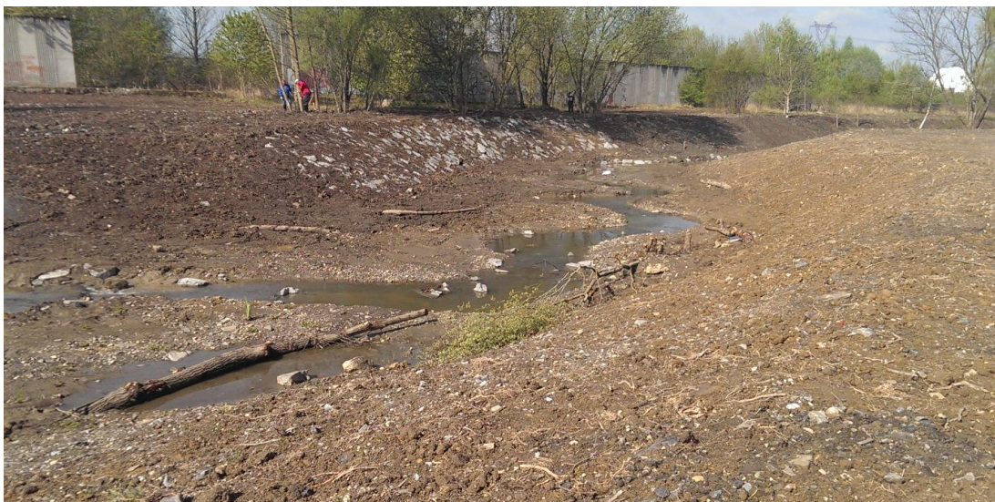
Obr. č. 29 - Realizace revitalizovaného koryta po odtoku z tůně v oblasti Na Vysoké zdroj VRV – Koterová
