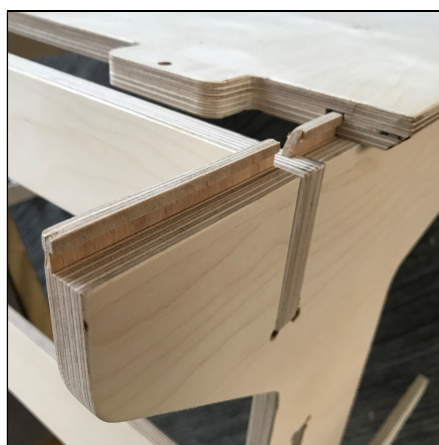
Obr. 23. - detail spojů pracovního stolu před zasunutím desky do své finální polohy
