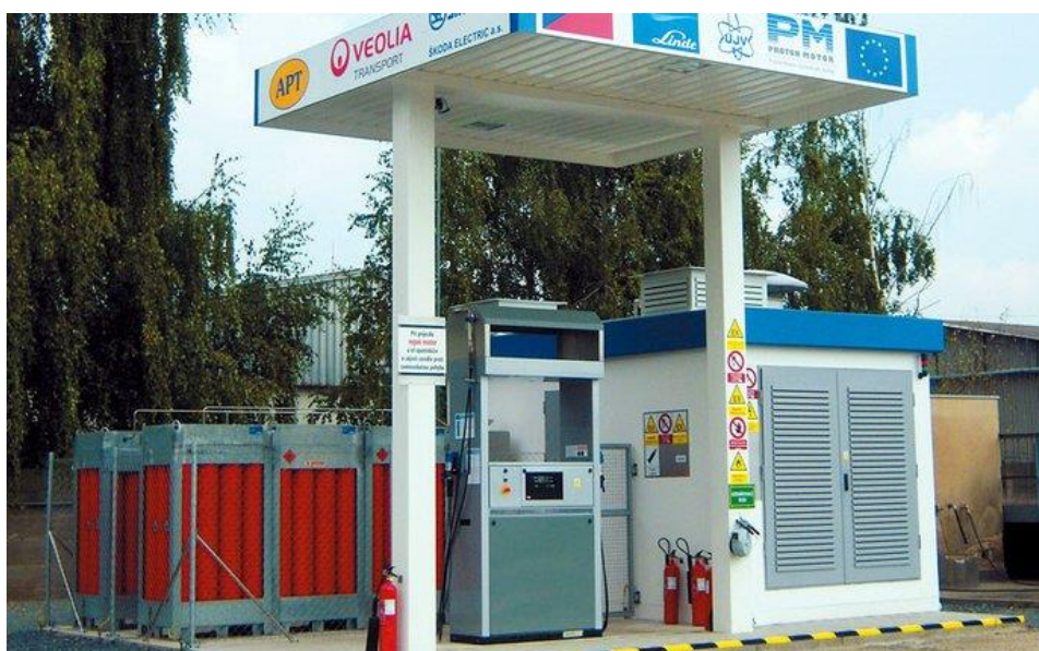
Obr. 15 Vodíková plnicí stanice v Neratovicích [57]
