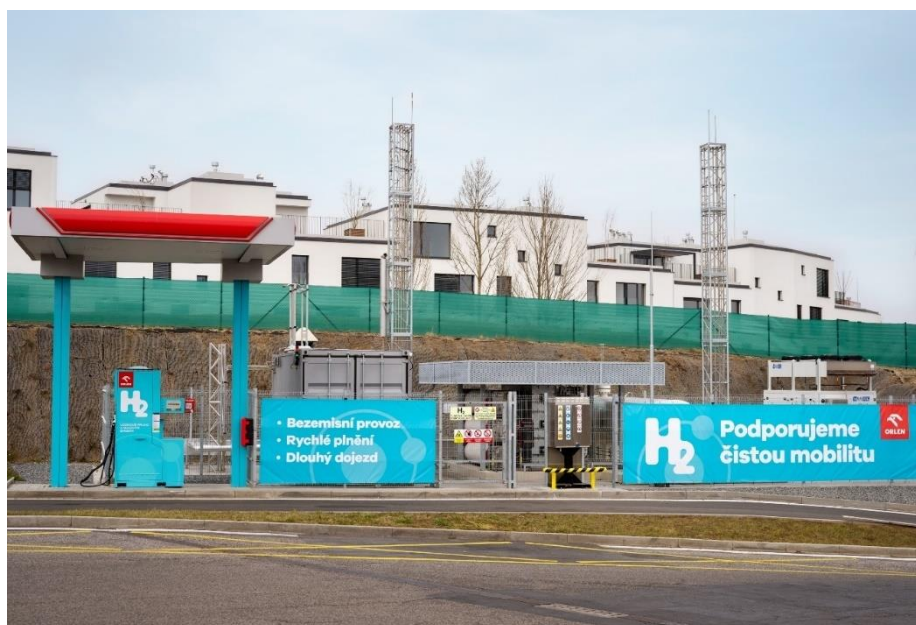
Obr. 17 Vodíková plnicí stanice na Barrandově [59]
