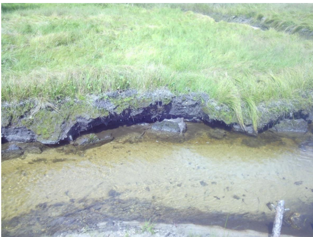
Foto č. 2: Nezpevněný břeh revitalizovaného potoka Hučiny, fotografováno 21. 8. 2014.
