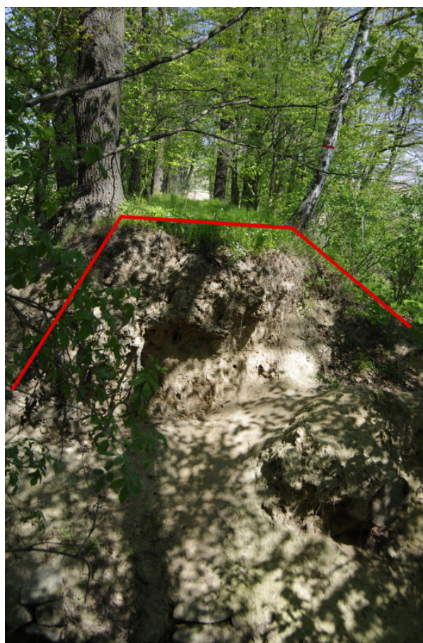
Obr. 6f: Průkop v hrázi Slavkovského rybníka nad současnou úrovní hladiny (autor: Petr Bradávka, 2016).
