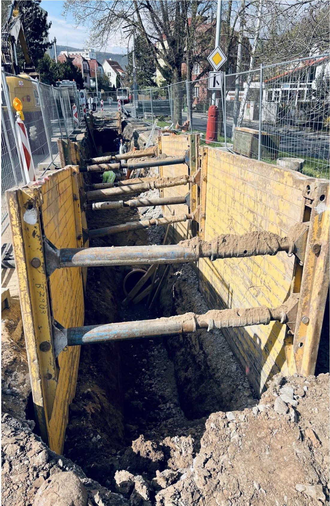
Příloha 4 –18. týden. Pokládání trubního materiálu. (zdroj vlastní, SVS a.s.)
