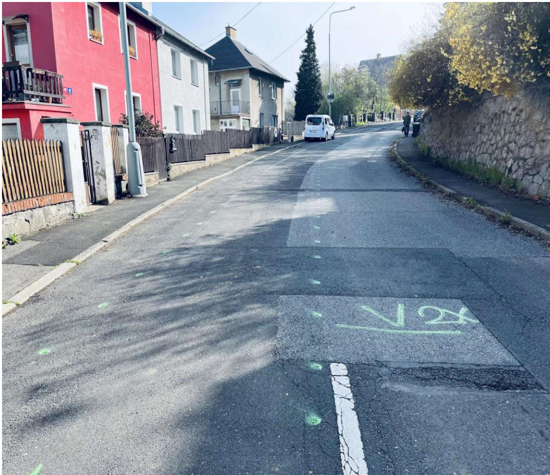
Příloha 1.– 3 týden. Vytyčení podzemních sítí. (zdroj vlastní, SVS a.s.)
