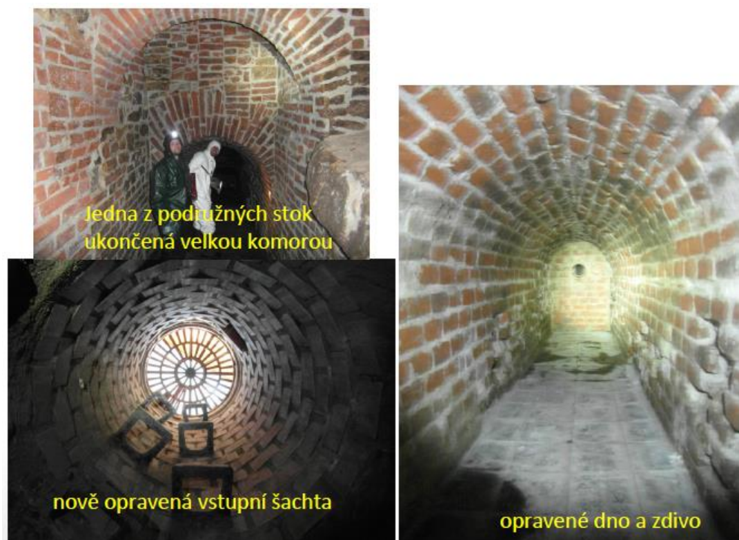
Obr. 28 - Průzkum s pořízením fotodokumentace kanalizační sítě (vlastní)
