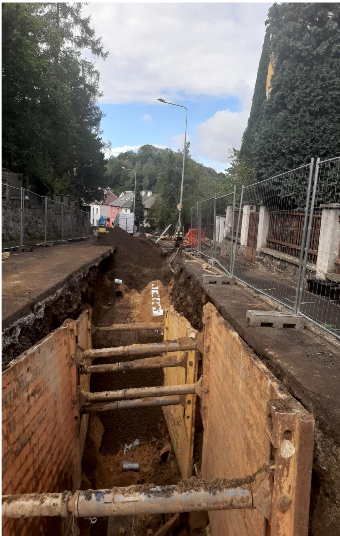
Příloha 7 – 30 týden. Výkopové práce. (zdroj vlastní, SVS a.s.)
