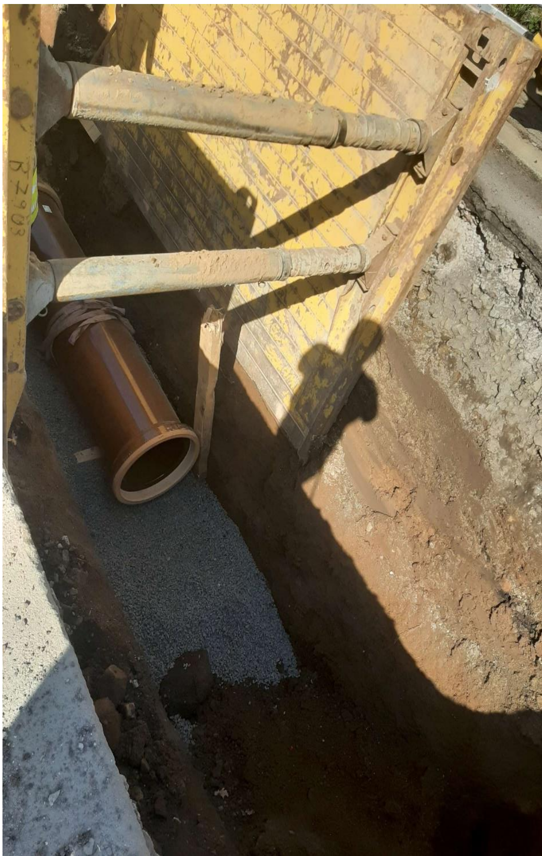
Příloha 5 – 18. týden. Uložení a podsypání trubního profilu DN KA 400. (zdroj vlastní, SVS a.s.)
