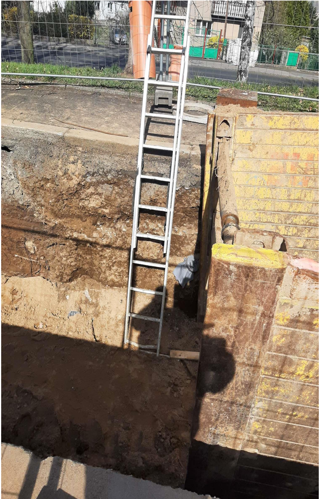
Příloha 3 – 14 týden. Uložení pažení. (zdroj vlastní, SVS a.s.)
