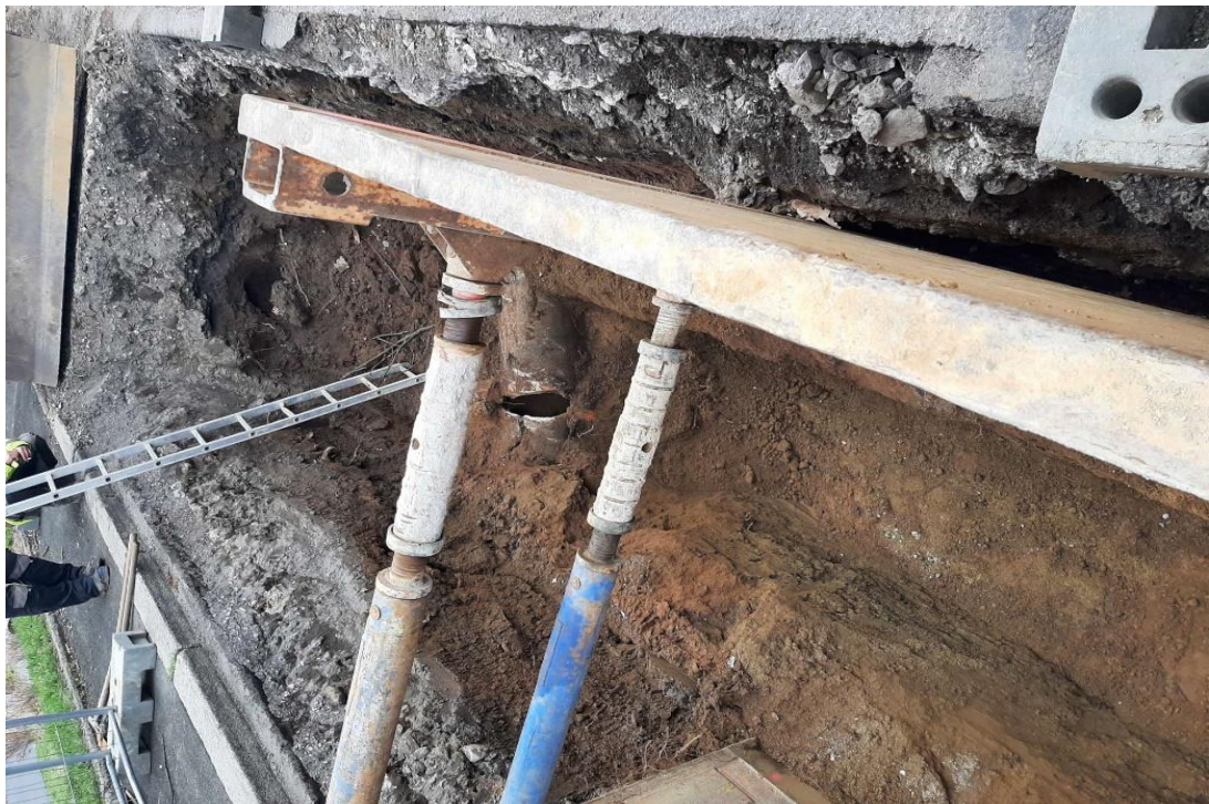
Příloha 2 – 6 týden. Započetí výkopových prací. (zdroj vlastní, SVS a.s.)
