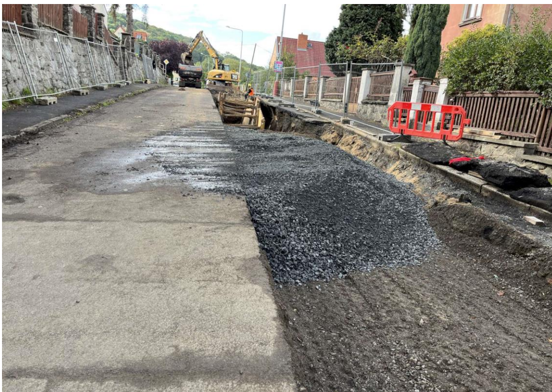
Příloha 8 – 32 týden. Zásypové práce. (zdroj vlastní, SVS a.s.)
