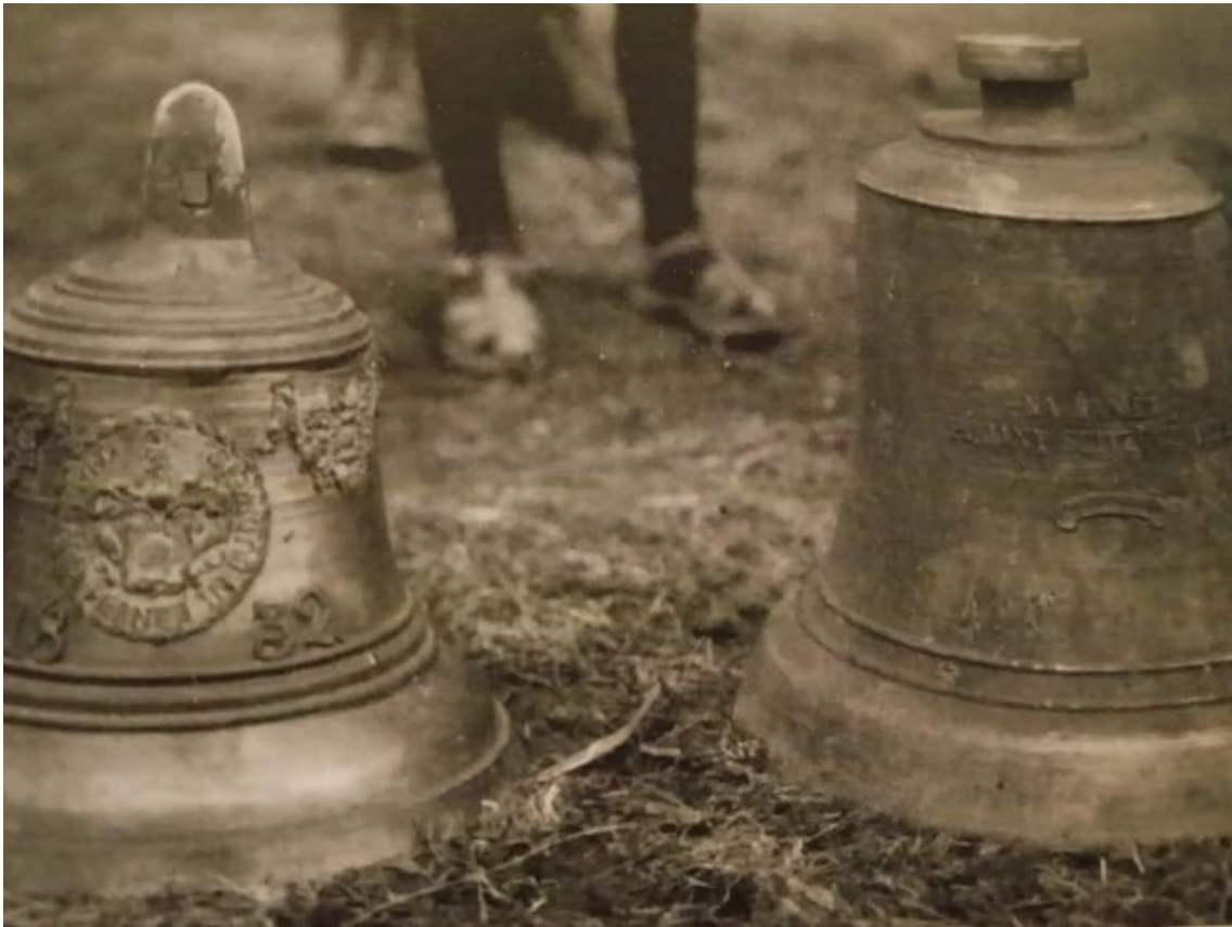
Obr. č. 19. Rekvizice zvonů z Kaple sv. Andělů Strážných v roce 1942. Vlevo zvon „umíráček“ z roku 1832, vpravo zvon „ Anděl Strážce “. Fotografoval kostelník Jan Krejčí
