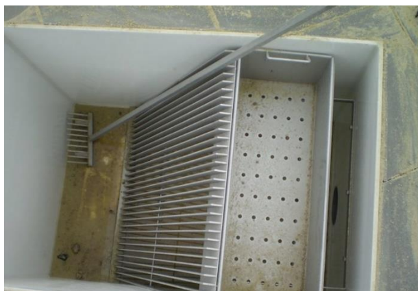
Obr. 9 Ručně stírané česle (zdroj: asio.cz)
