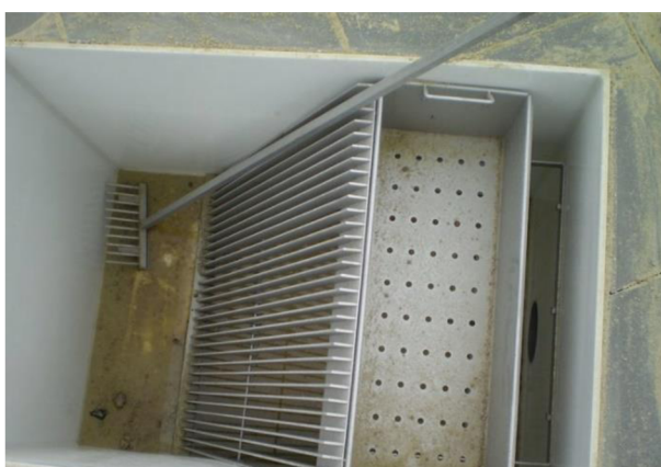
Obr. 9 Ručně stírané česle (zdroj: asio.cz)
