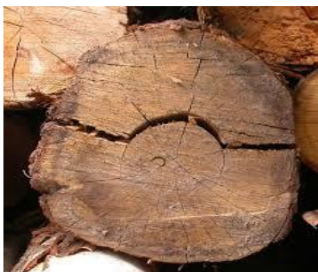
Obr. č. 24 Výsušné trhliny
