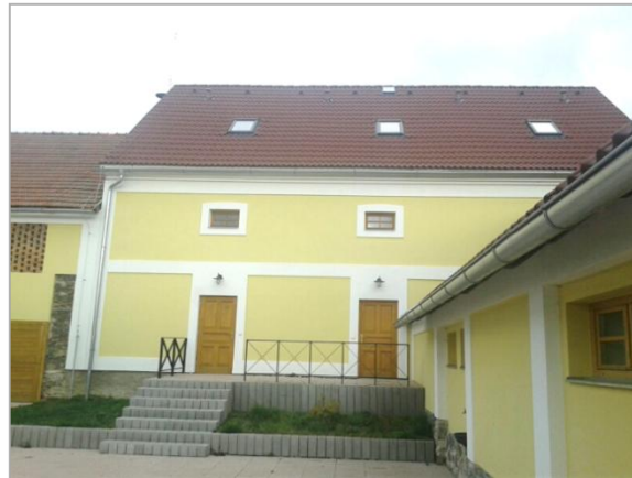
Obrázek 4: Ubytovací a stravovací objekt
