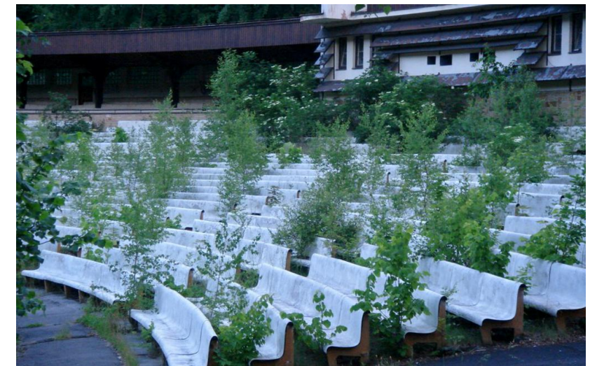
Obrázek 24 Letní kino Karlovy Vary před rekonstrukcí
