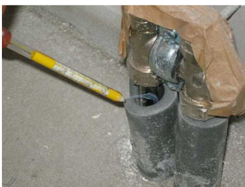
Obr. 18 Prostup rozvodů otopné soustavy
