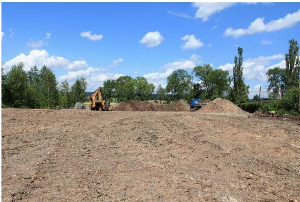
Obr. C2: Stavba sběrného dvora – foto 2
