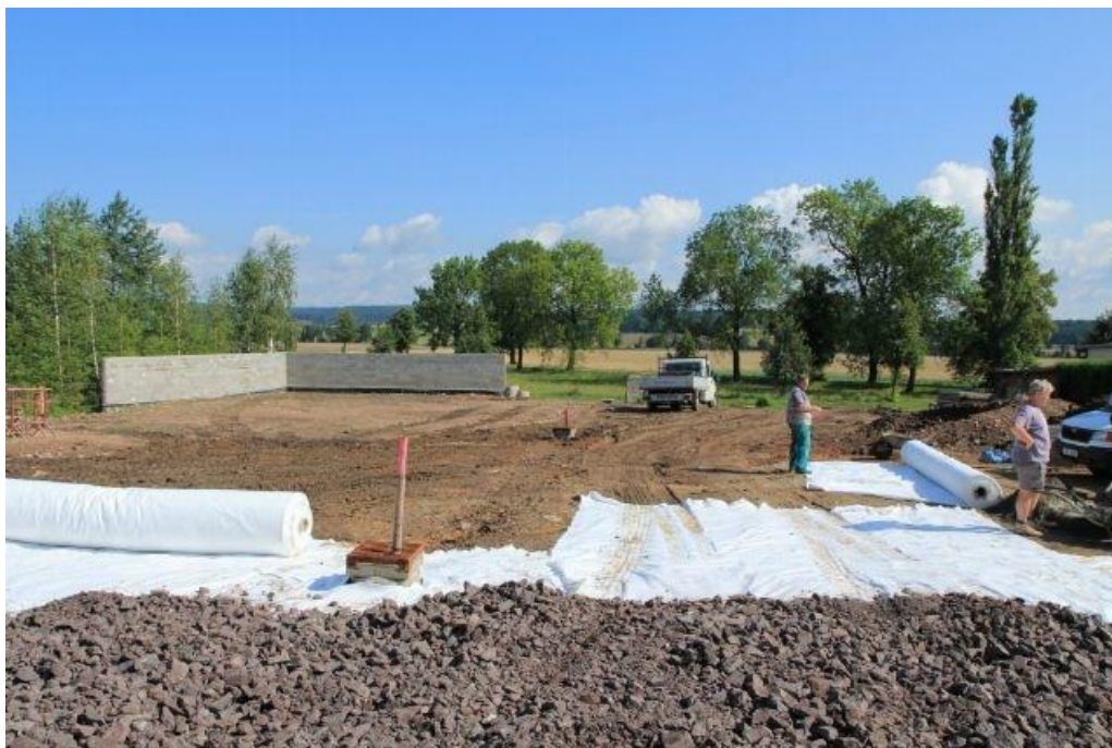
Obr. C1: Stavba sběrného dvora – foto 1
