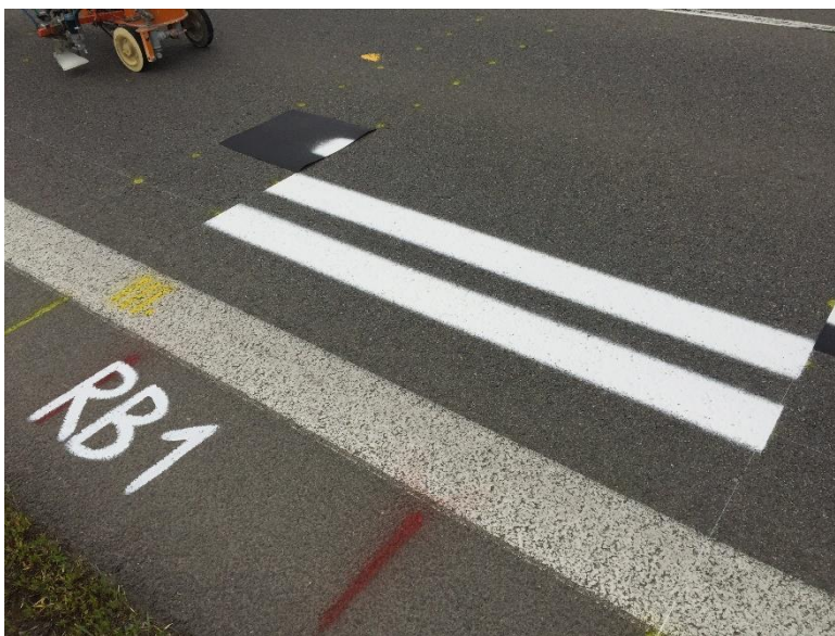
Obrázek č. 22: Pokládka vzorku RB1
