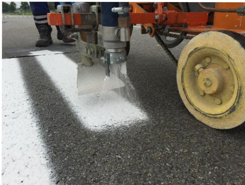
Obrázek č. 20: Detail pokládky vzorku VB2
