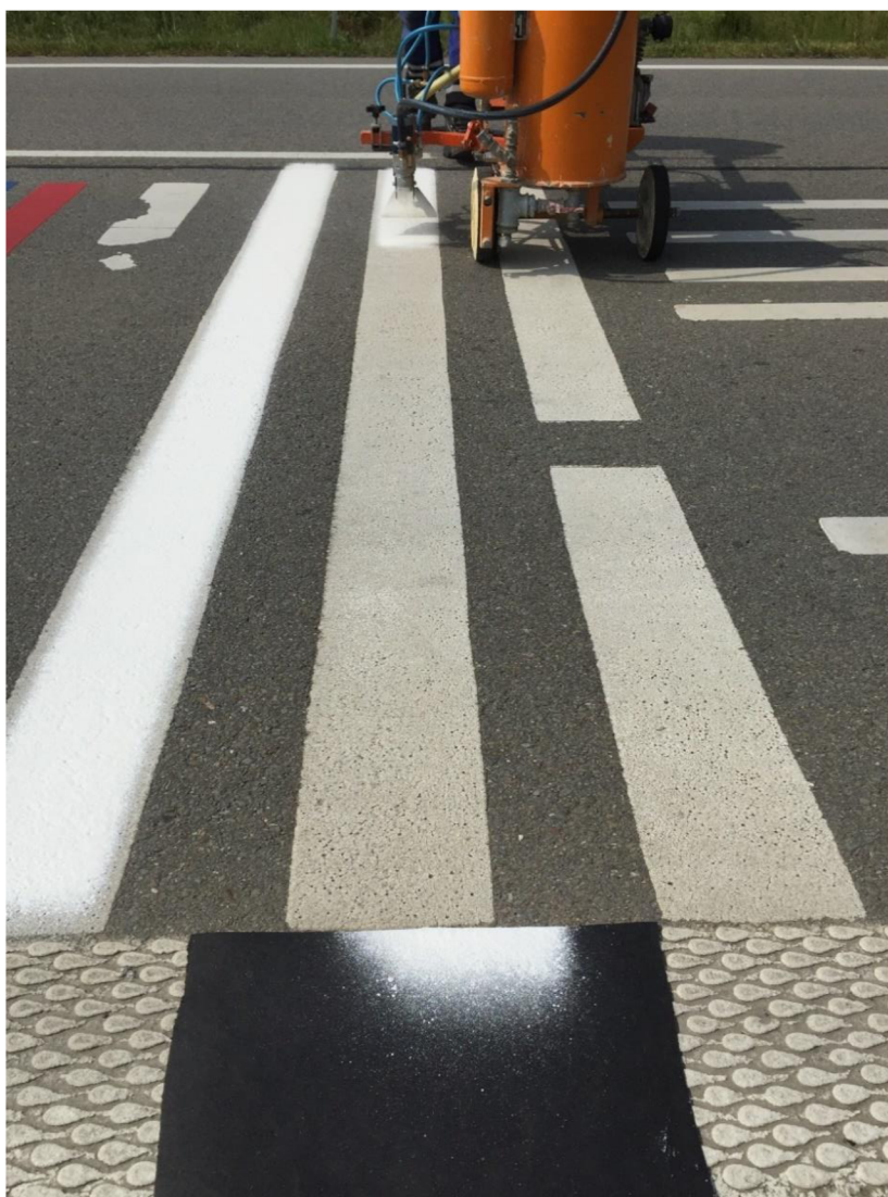
Obrázek č. 34: Vzorek TPP 118 – vzorek v příčném směru
