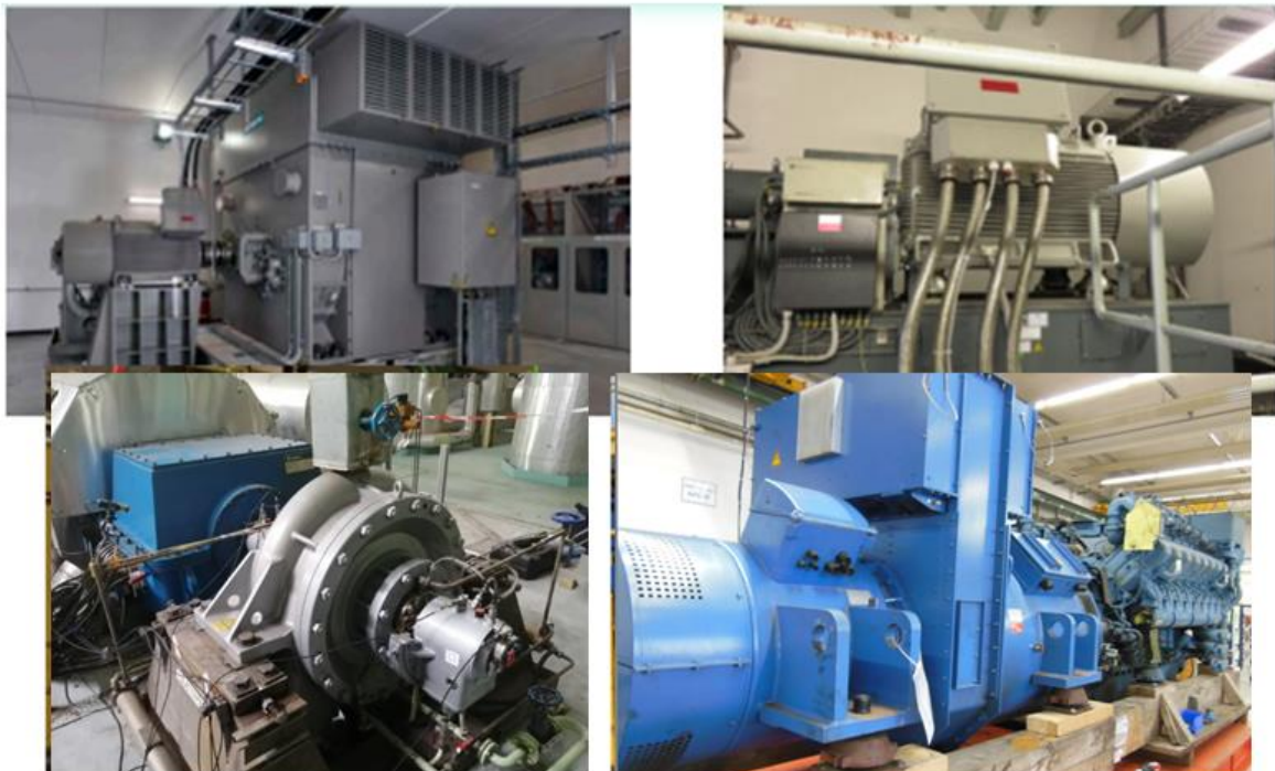
Obr. 1) Příklady pohonů s proměnlivými otáčkami (zkratový generátor, ventilátor, čerpadlo s hydrospojku a turbínou a dielelektrické soustrojí)
