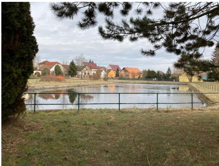
Příloha č. 11 – Hasičská nádrž – Stará osada
