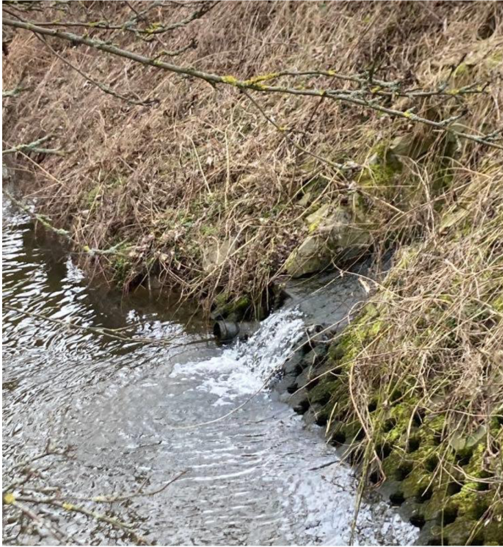
Příloha č. 3 – Vyústění z ČOV Okříšky – detail
