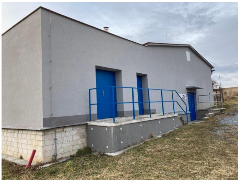
Příloha č. 6 – Úpravna vody Hvězdoňovice
