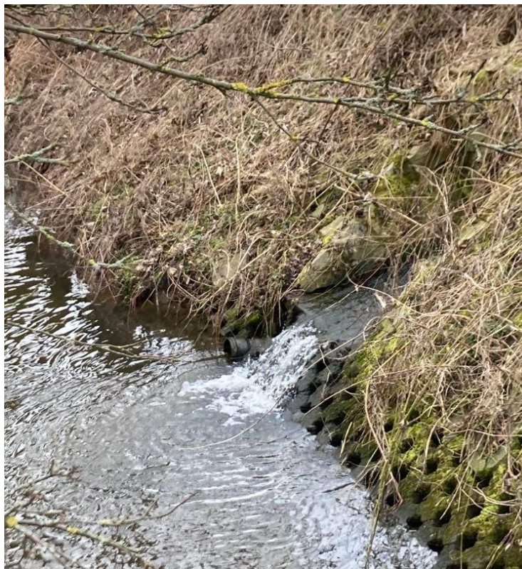
Příloha č. 3 – Vyústění z ČOV Okříšky – detail
