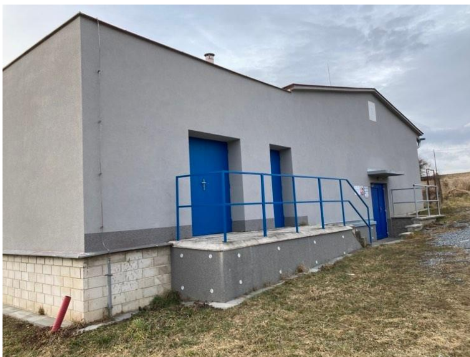
Příloha č. 6 – Úpravna vody Hvězdoňovice
