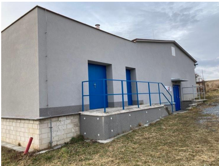
Příloha č. 6 – Úpravna vody Hvězdoňovice
