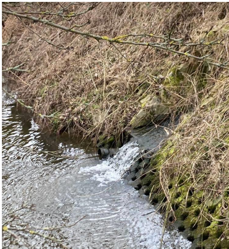
Příloha č. 3 – Vyústění z ČOV Okříšky – detail
