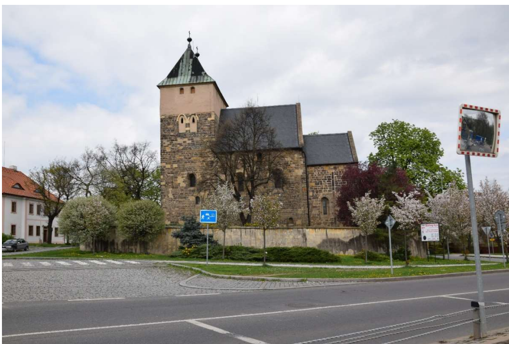
Obr. č. 17: Kyje – historické jádro obce (kostel sv. Bartoloměje) – dříve byl kostel v centru obce a hlavní komunikace zde procházela skrze obec, u kostela stávala farní budova, dnes již farní budova nestojí a kolem kostela je pás veřejné zeleně, zároveň obcí prochází velmi frekventovaná silnice, která tak narušuje charakter místa jakožto návsi a komunitního prostoru.
