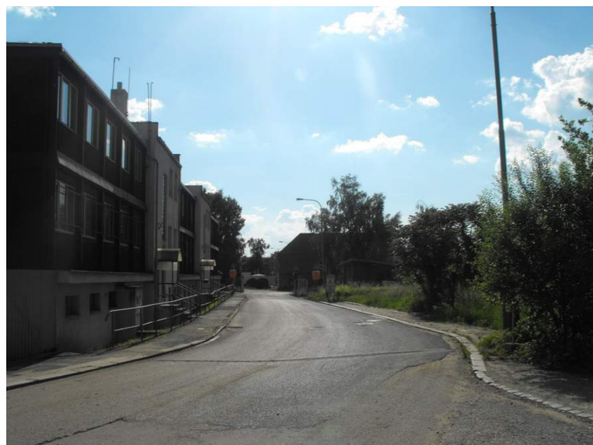
PŘÍCHOD DO AREÁLU OD MOSTU BARIKÁDNÍKŮ
