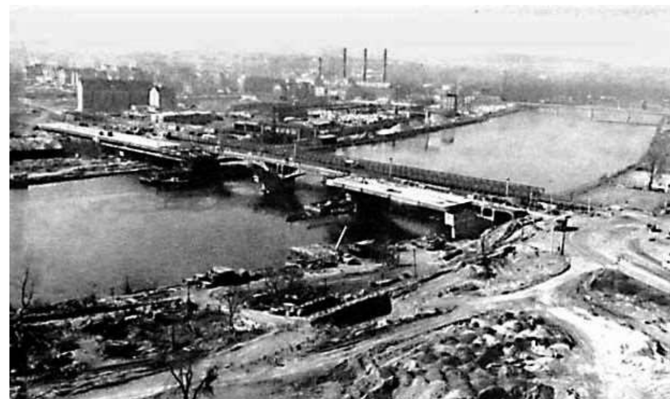
Obrázek 29: Stavba nového mostu Barikádníků. Pohled od Pelc-Tzrolky k Holešovicím
