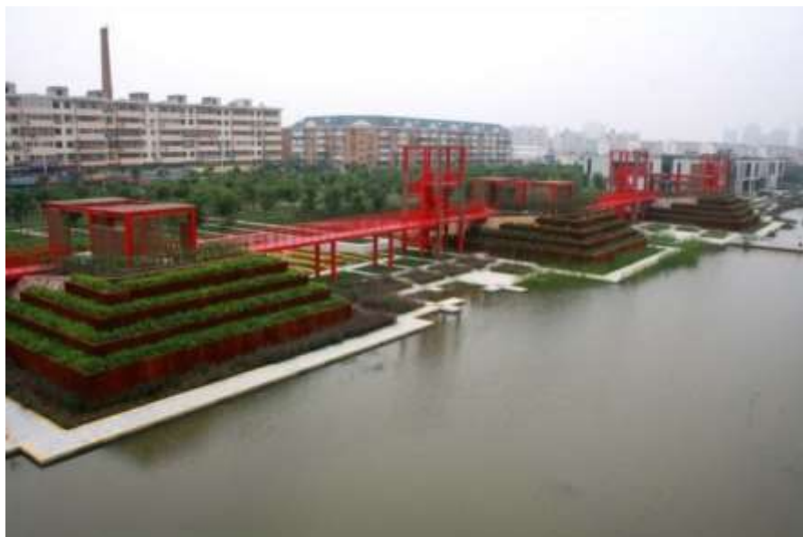
Obrázek 14: Tianjin bridged gardens (Tchien-ťin, Čína)
