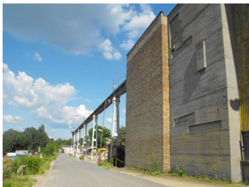
STĚNA BUDOVY PANELÁRNY
