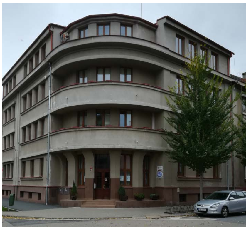
Obrázek č. 1. budova školy – zdroj vlastní
